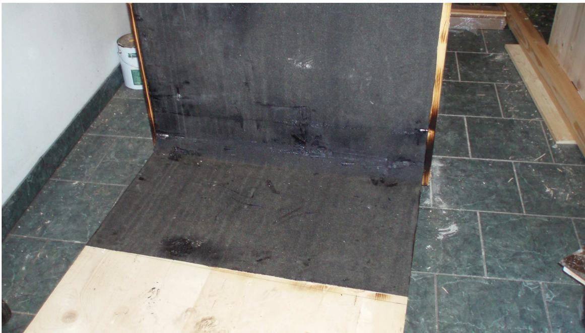
**Abb. 18 Bitumenkaschierte Auflämmplatte an der Außenseite des Oberteils**
