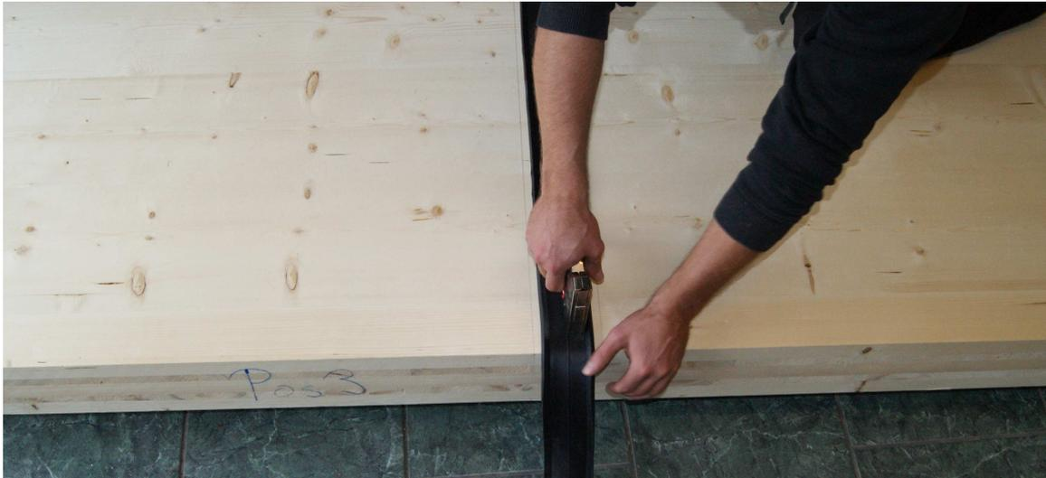
**Abb. 13 Montage des Dichtbandes an der Deckenoberseite**
