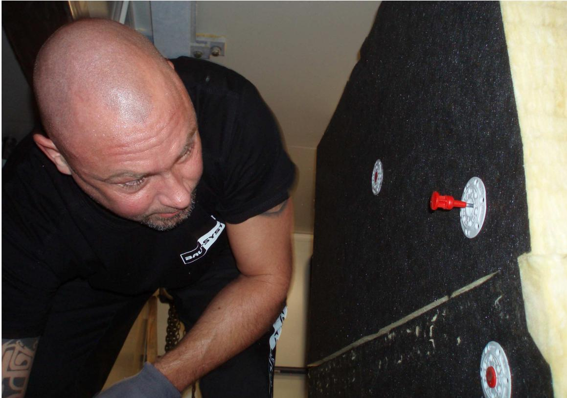
Abb. 34 Anbringen der Fassadendämmung
