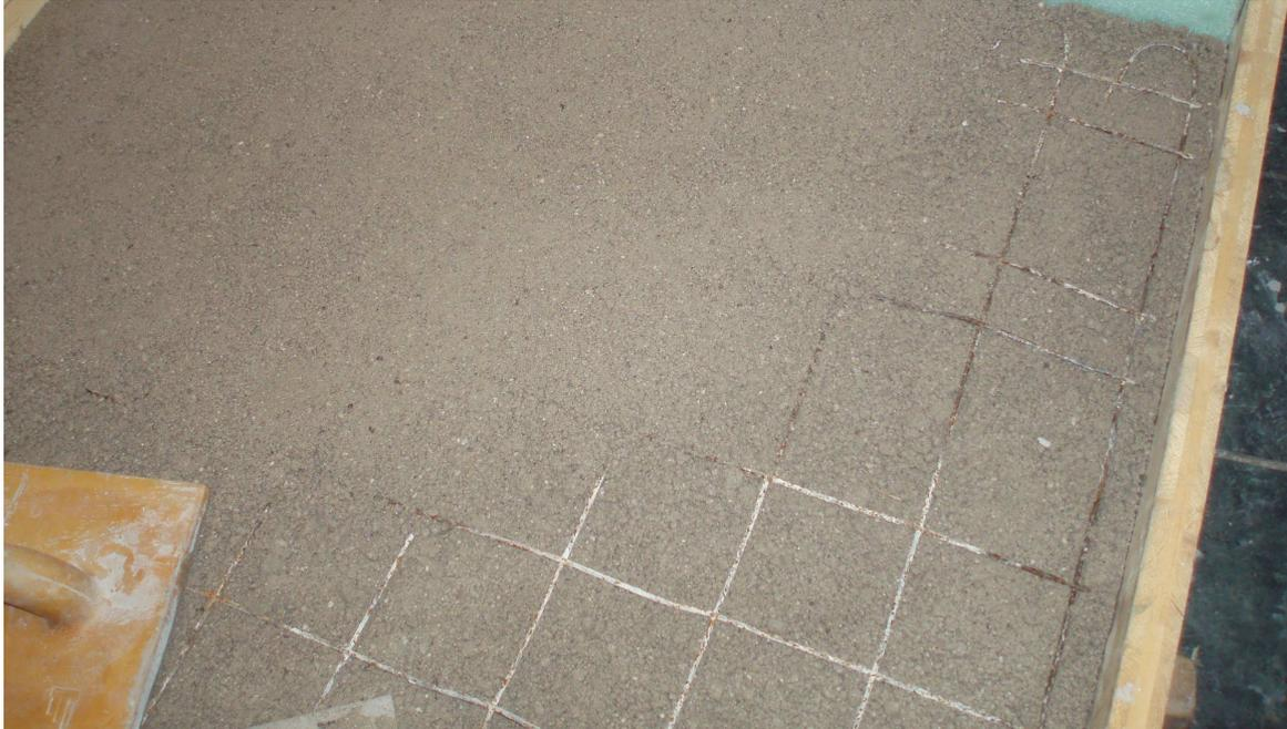
**Abb. 26 Betonieren des Estrichs**
