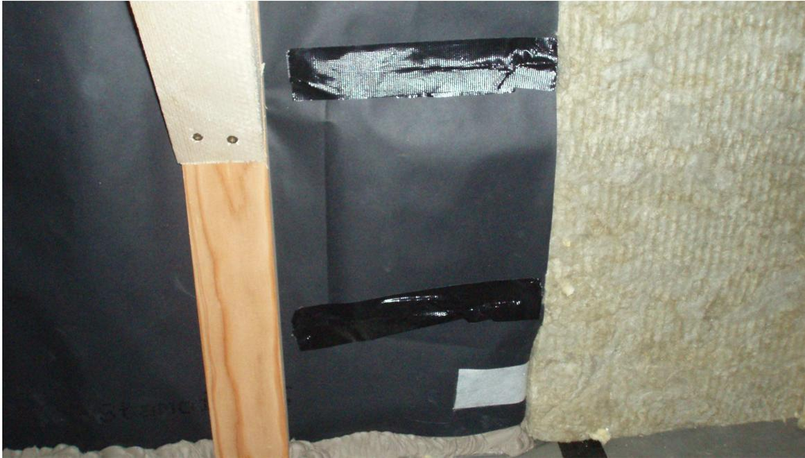
**Abb. 42 Verschlossene Öffnung Messpunkt 25**
