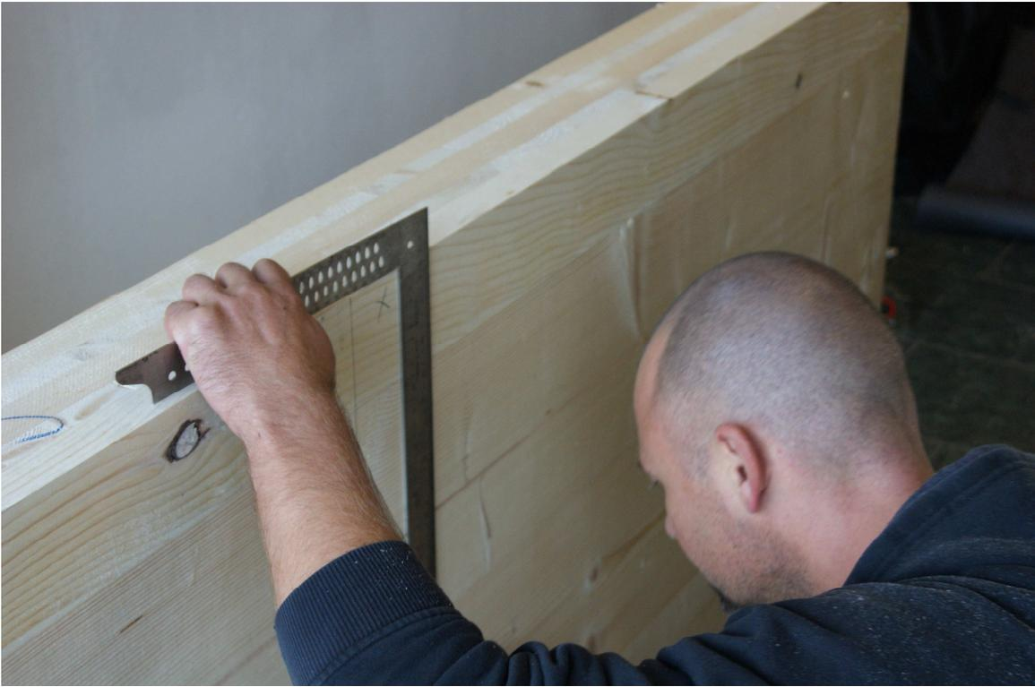
Abb. 11 Anreißen der Deckenplatte
