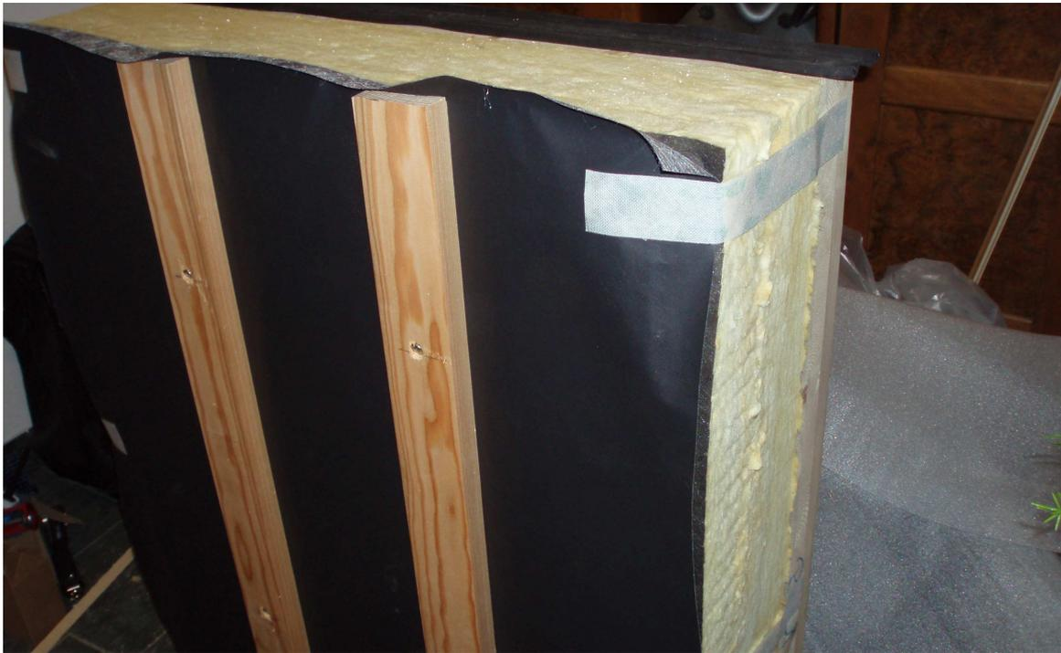
**Abb. 17 Transportfertiger Unterteil, Erdgeschossplatte**
