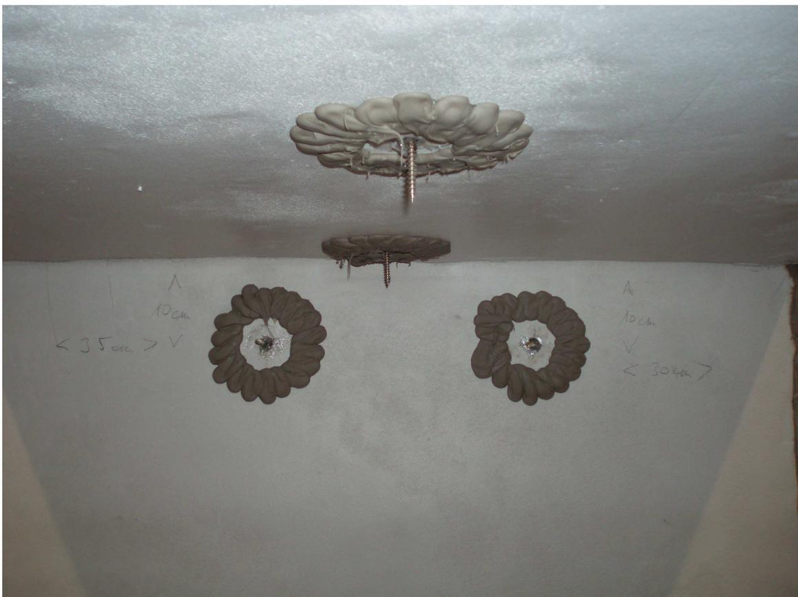
Abb. 47 Abgedichtete Bohrkern der Messstellen 2,3,6 und 7
