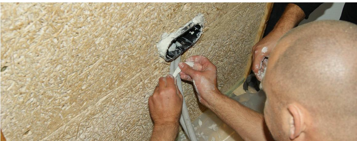
**Abb. 21 Einbau der Doppelsteckdose**
