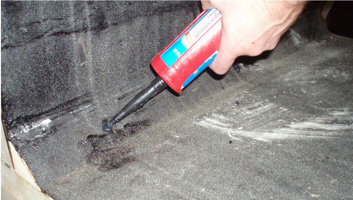
Abb. 32 Verpressen der Einschraublöcher mit Dichtmasse
