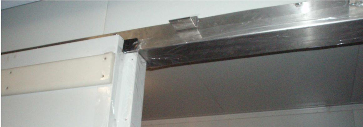
Abb. 29 Abkleben der Seitenteile
