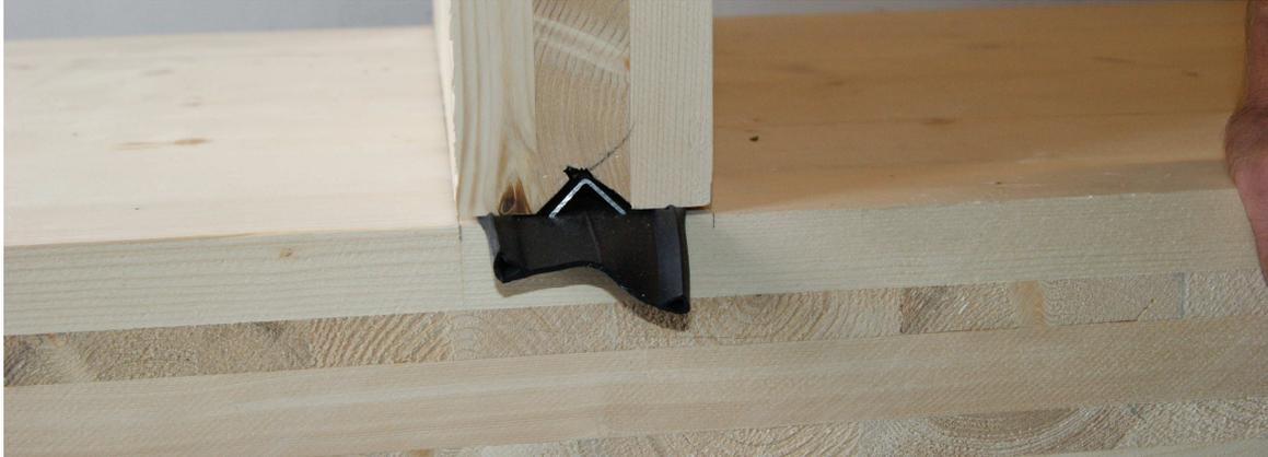
**Abb. 15** Zentrierte Obergeschossplatte inklusive Abdichtung
