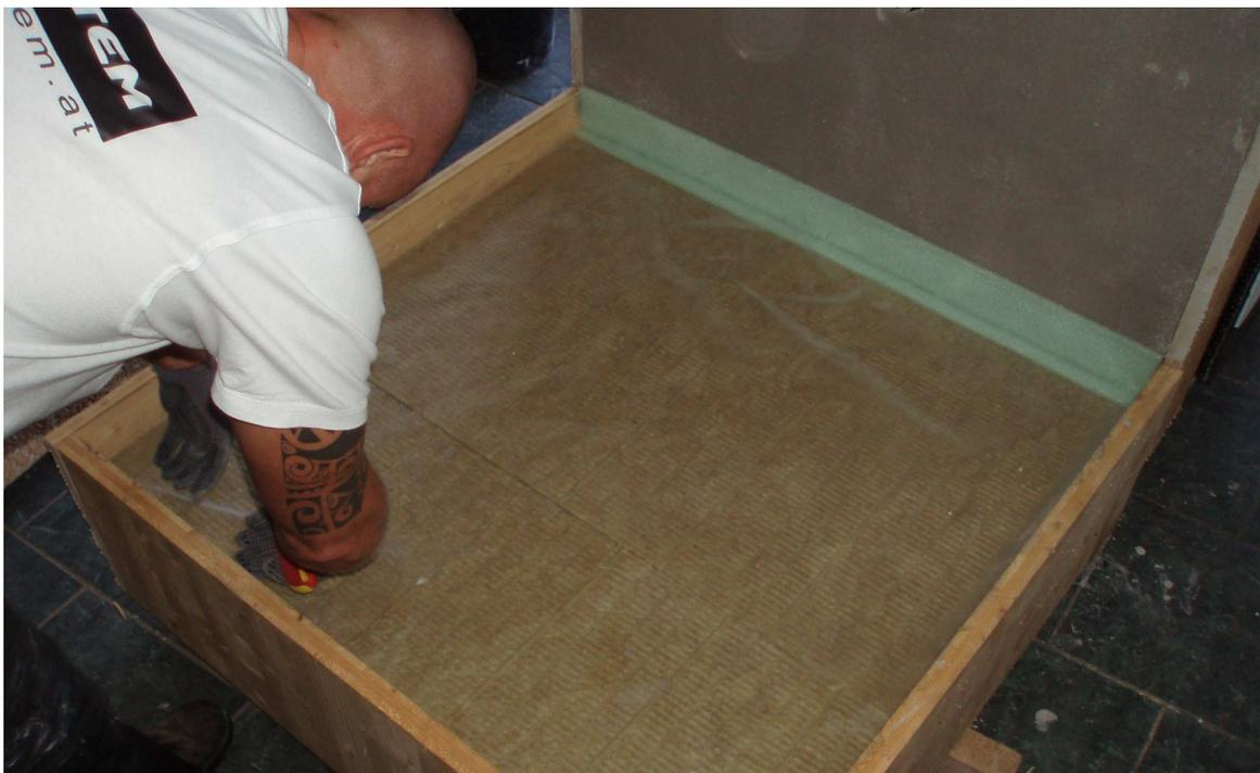
Abb. 25 Verlegen der Gleitschicht
