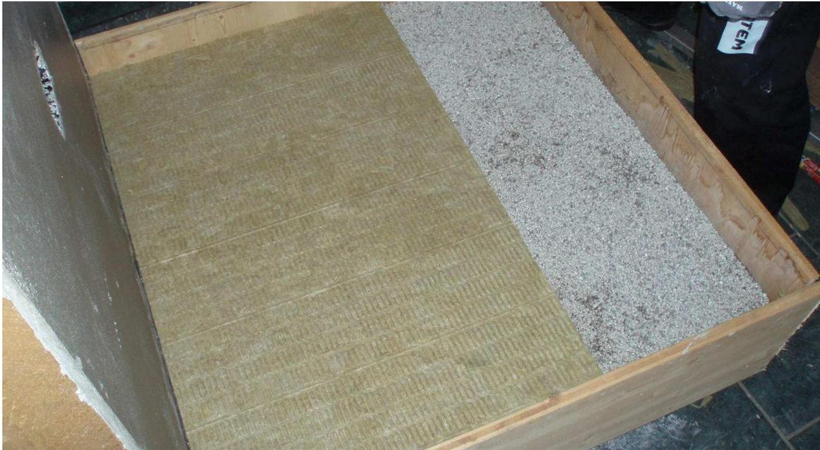
Abb. 24 Verlegen der mineralischen Trittschalldämmung
