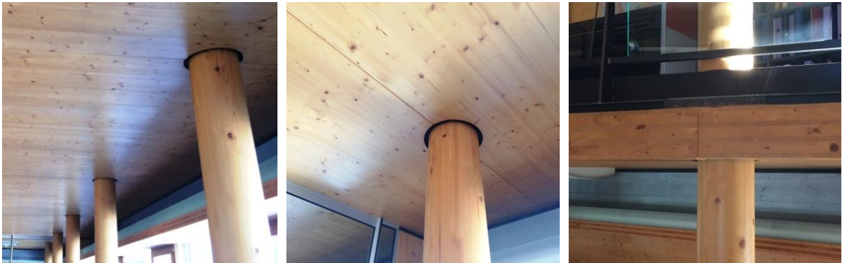
Abb. 1-2—3 Punktgestützte BSP-Platten im Bürogebäude der KLH Massivholz GmbH in Frojach - Katsch
