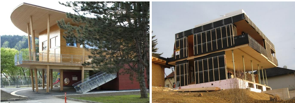
Abb. 1-2—2 Ausführungsbeispiele punktgestützter Brettsperrholzplatten (vgl. [1], Kap. B)
