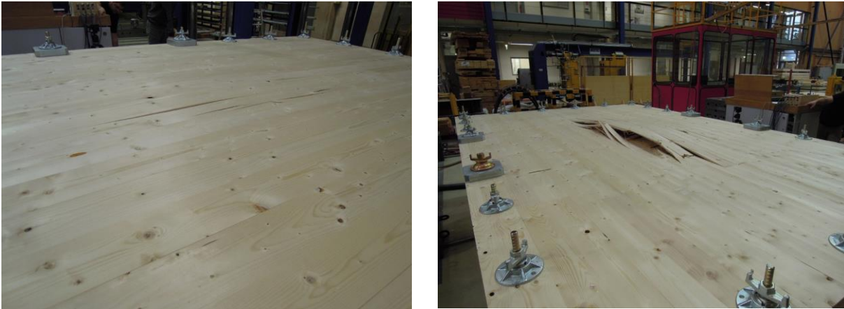
Abb. 2-3—12 Während der Prüfung aufgetretene Risse in der Decklage (links), Bruchbild nach Beendigung der Prüfung (rechts) des Prüfkörpers B_B_7s-2 [5]
