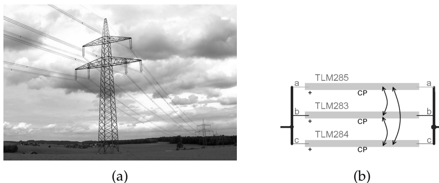
Bild 5.14.: Modellierung der Freileitungen in EMTP-RV. (a) Foto 380-kV-Freileitung, (b) Modellelement
