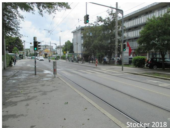
Abbildung 83: VLSA gesicherter Schutzstreifen beim Schulzentrum St. Peter
