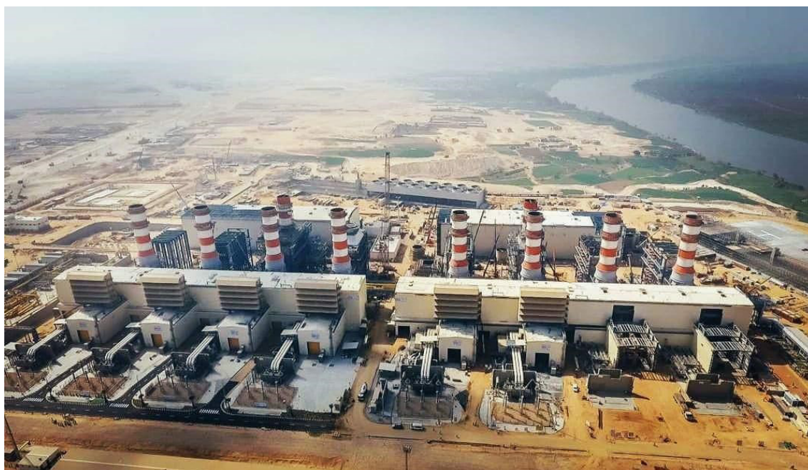
Abbildung 22: GuD-Kraftwerk Beni Suef (4.800 MW) (MEC 2014)
