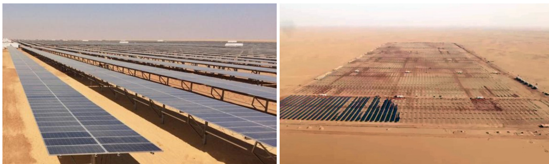
Abbildung 28: Solarpark Benban. Sich selbst justierende Kollektoren (links) (Ossenbrink 2018) und Luftaufnahme des entstehenden Solarparks (rechts) (Egypt Today 2018a)
