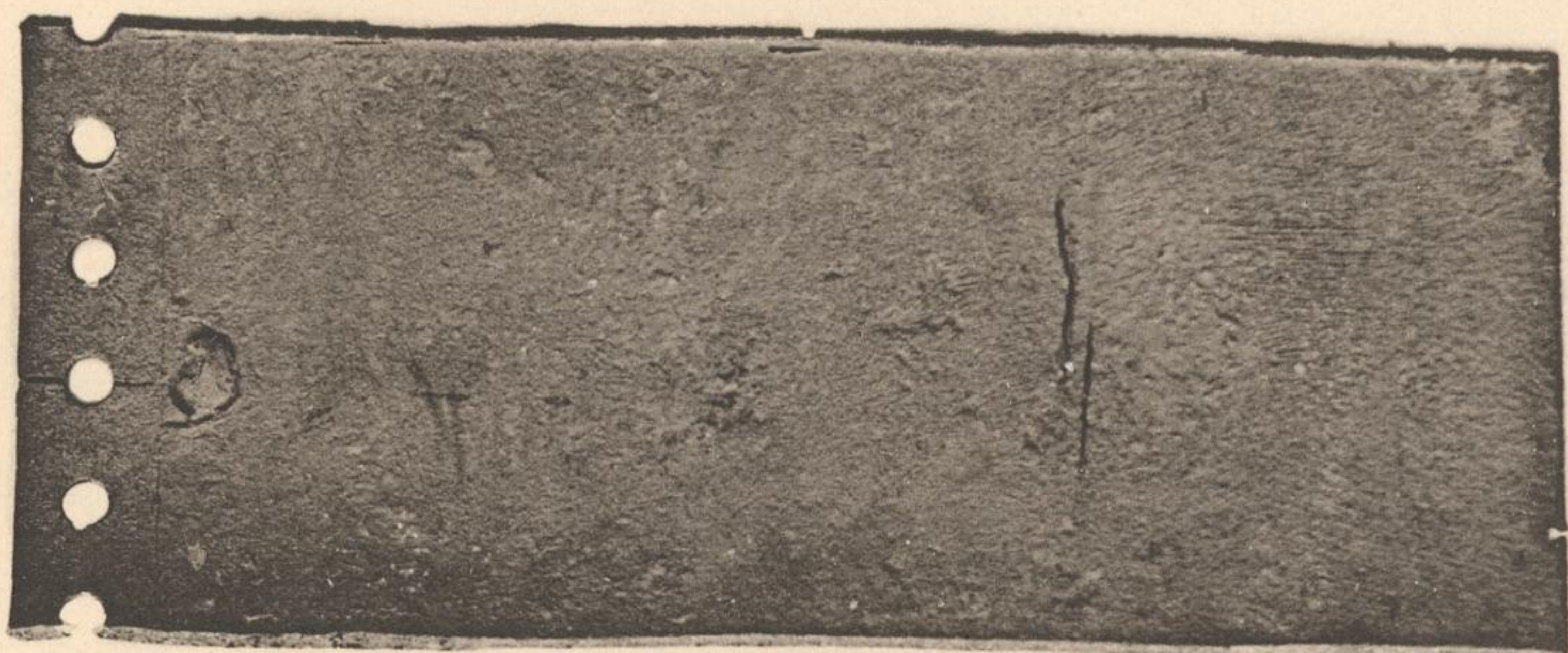
Riss in der Kesselwand (Innenseite).
