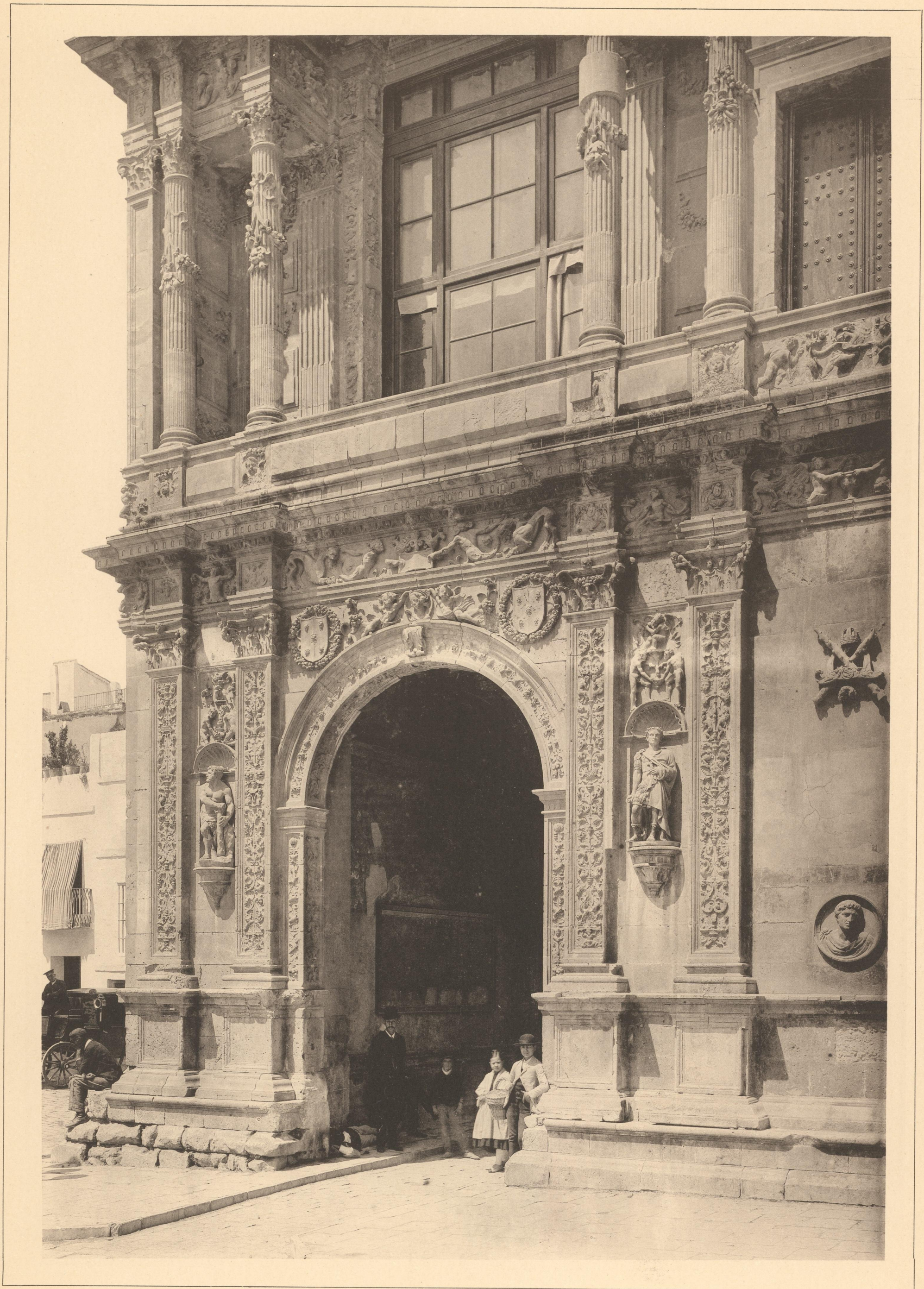
SEVILLA FASSADENTHEIL DES RATHHAUSES
