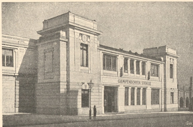
Stadtbahn- Haltestelle Gumpendorfer- strasse.
