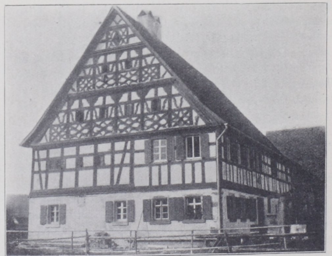
Abb. 36. In Eckartsweiler bei Dombühl.
