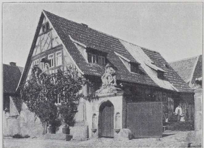
Abb. 33. In Obertheres bei Haßfurt.
