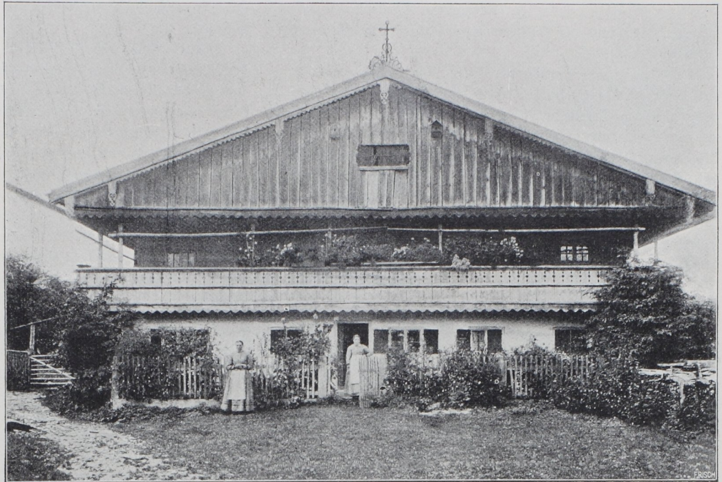
Abb. 7. Straßerhaus in Schlegeldorf, Isarwinkel.
