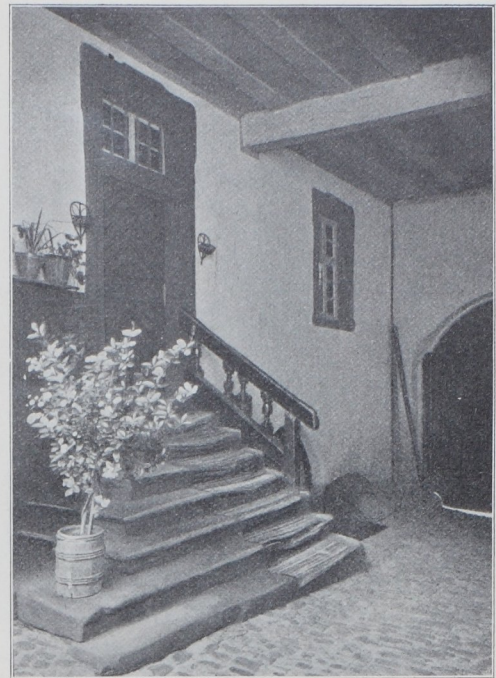
Abb. 10. Überbaute Hofeinfahrt mit Treppe zur Wohnung und Kellerzugang in Hambach. ca. 1750. [Vom Fenster aus ist der Eingang zu übersehen.]
