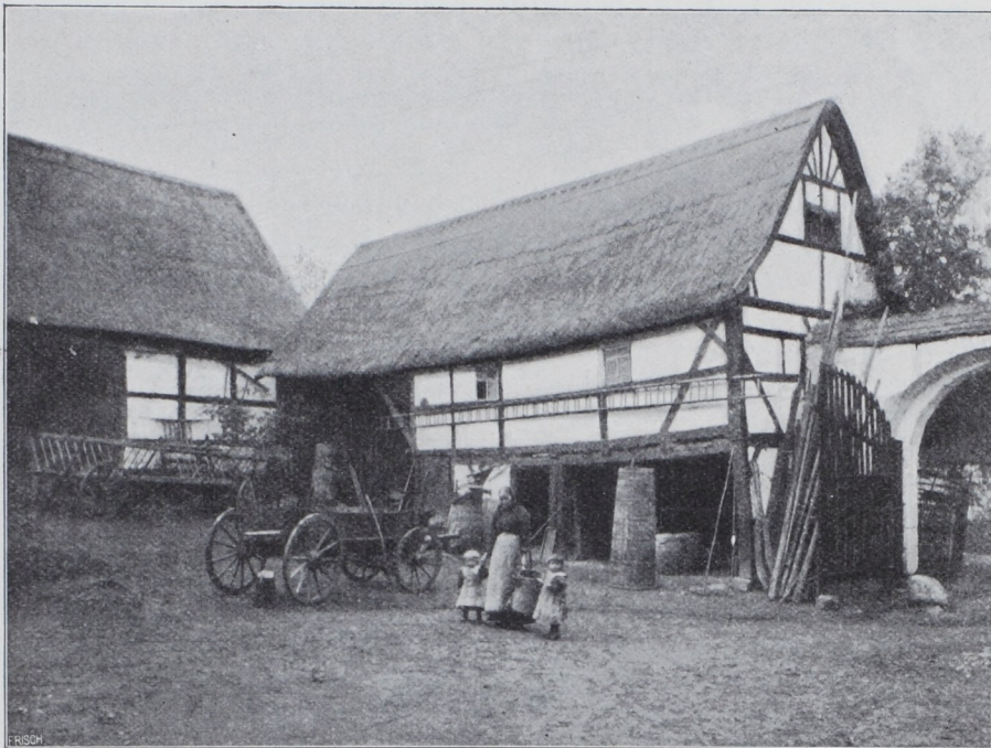
Abb. 12. Schuppengebäude eines Gutsgehöftes zu Babisnau (Bez. Dresden).
