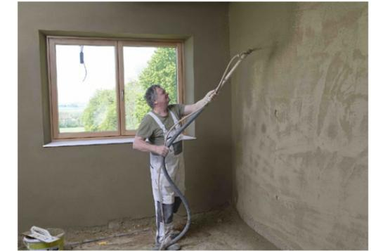
Abb. 151 | Maschineller Auftrag eines Lehmputzes
