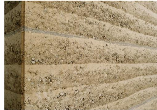
Abb. 143 | Stampflehmwand in Sichtqualität mit typischem Schichtenaufbau. Die steinigen Lehme erzeugen eine raue, haptische Oberflächenqualität.
