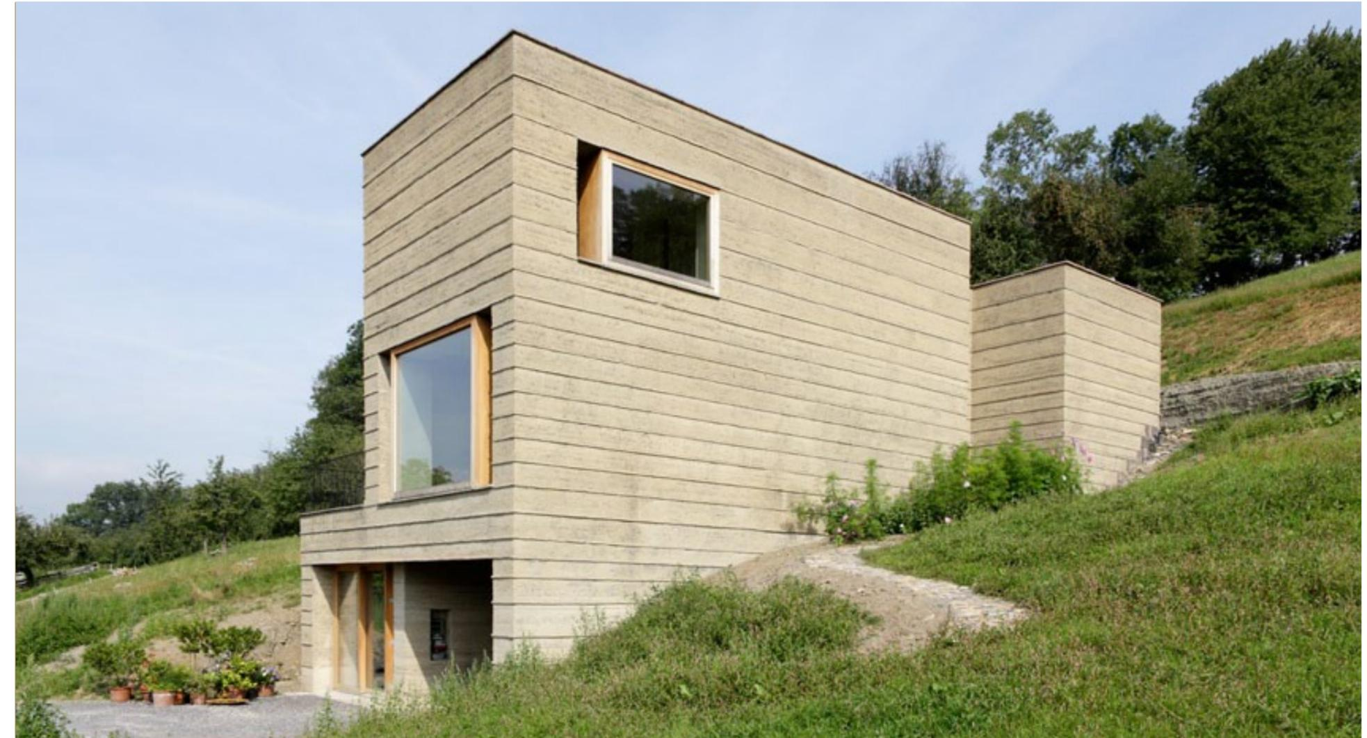
Abb. 157 | Haus Rauch von außen. Das Wohnhaus in Schlins aus dem abgegrabenen Lehmmaterial des eigenen Baugrundes errichtet.
