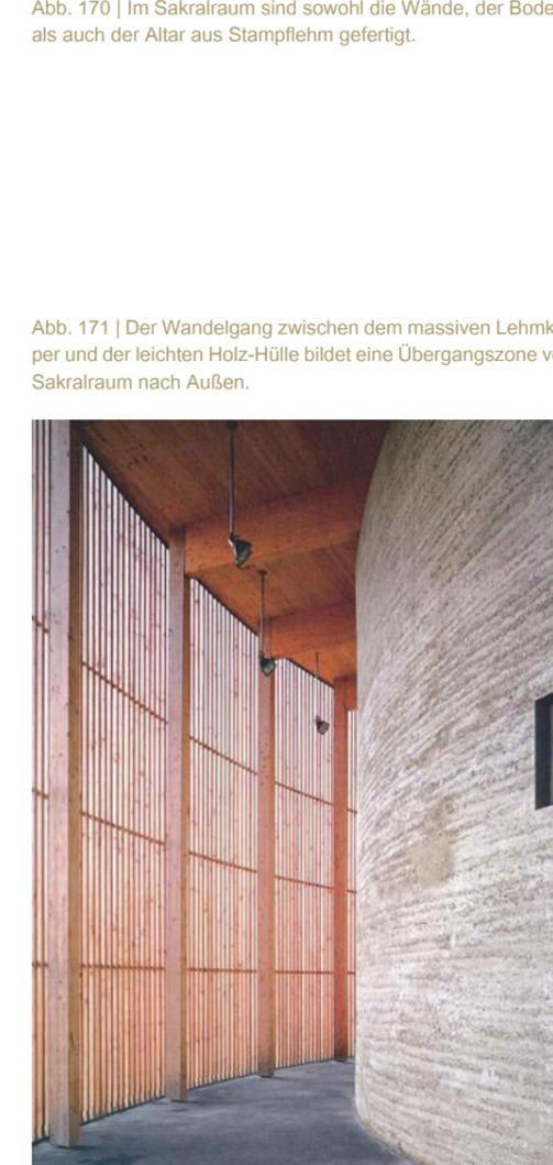
Abb. 171 | Der Wandelgang zwischen dem massiven Lehmkörper und der leichten Holz-Hülle bildet eine Übergangszone vom Sakralraum nach Außen.
