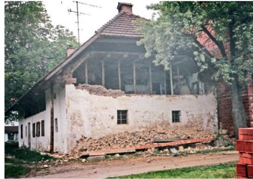
Abb. 89 | Die historische Ostwand des Hauses wurde in den 90er Jahren im Zuge eines Zubaus abgetragen. Die dahinter liegenden Räume blieben samt Decken intakt. Rechts ist der vorspringende Stallbau der 70er Jahre zu sehen.
