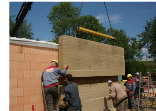
Abb. 147 | Versetzen von Fertigteilen für eine Stampflehm-Schale mittels Baukran
