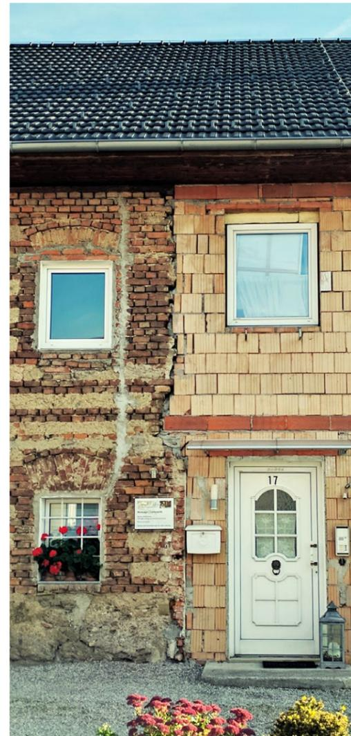
Abb. 46 | Übergang von historischem Ziegel-Schichtenbau zu zeitgenössischem Dämmziegel.
