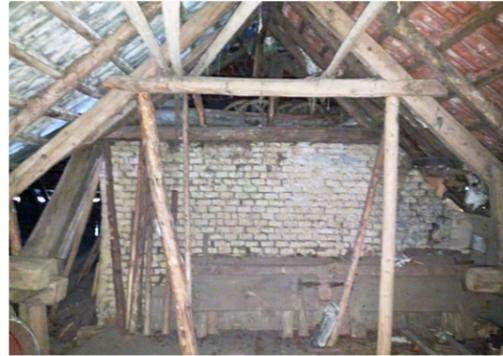
Abb. 73 | Zum Dachraum hin unverputzte Lehmziegelmauer der westlichen Dachkammer.
