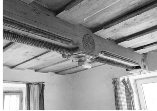
Abb. 104 | Geschnitzter Unterzug und profilierte Holzdecke in der Auszugskammer [11]
