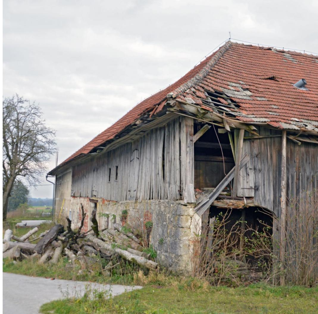
Abb. 53 | Einfallende Hausecke: Das schadhafte Dach mit eindringender Nässe ist ein wesentlicher Ausgangspunkt des Verfallsprozesses. Das hier gezeigte Gebäude ist bewohnt. Hier fehlt es an der nötigen Wertschätzung und Instandhaltung.
