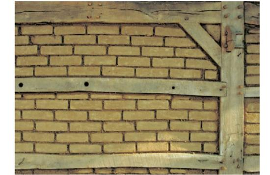
Abb. 145 | Holzkonstruktion mit Lehmstein-Ausfachung
