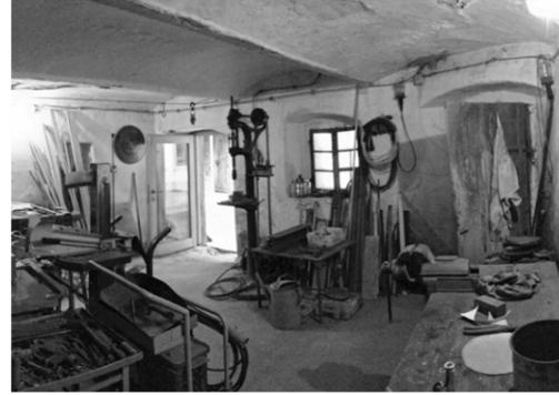
Abb. 106 | Die Werkstatt [13] war früher der Kuhstall des Hauses. Links Tür und Fenster zum Innenhof, rechts die Tür zum Vorhaus. Zwei Eisenträger dienen als Mittelaufleger des Dreifach-Tonnengewölbes.
