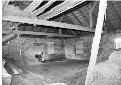
Abb. 115 | Heuboden [30], nördlicher Bereich. Mit Lochziegeln vermauerte Fenster gewährleisten die Belüftung des Bereiches.
