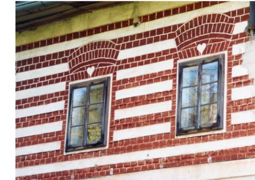
Abb. 29 | Vorgetäushtes Ziermauerwerk um die Fenster. Das weiße Fugenbild ist aufgemalt und entspricht nicht dem darunter liegenden Ziegelraster. Kronegger, Voitsdorf, Ried im Traunkreis
