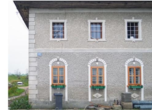
Abb. 35 | Putzfaschen zur Geschoßtrennung, als ausgeprägte Fensterzier und zum Andeuten von Ecksteinen.
