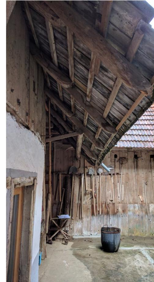
Abb. 74 | Die Sparren der Dachkonstruktion über dem Kuhstall wurden nachträglich verlängert und damit der Dachvorsprung erhöht, um die wahrscheinlich nach außen versetzte Mauer ausreichend vor Bewitterung zu schützen.
