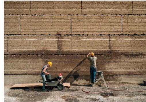
Abb. 165 | Die Fugen der Fertigteile werden mit Lehm ausgefüllt, eine monolithische Oberfläche entsteht.
