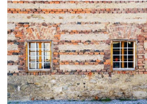
Abb. 28 | Ziegelrahmung um das Fenster im Schichtenmauerwerk mit scheinrechtem Bogen, weiße Fenstergitter Syböck zu Voitsdorf, Voitsdorf, Ried im Traunkreis
