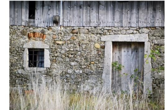
Abb. 30 | Steinerne Einfassung von Tür und Fenstern im Feldsteinmauerwerk mit geziegeltem Entlastungsbogen über dem Fenster. Häusl beim Mayr zu Edt, Umland Voitsdorf, Ried im Traunkreis
