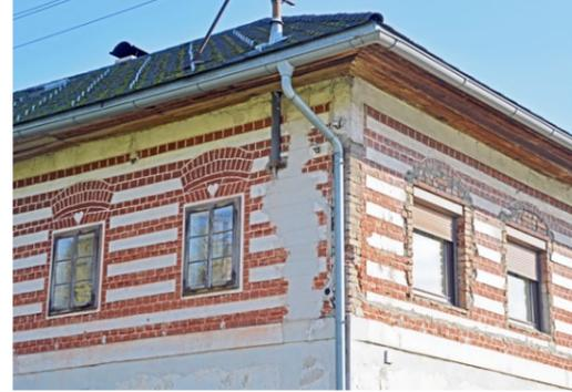
Abb. 49 | Links: Historisches Doppelfenster mit Glasteilung; Rechts: Neue Fenster mit Rollo-Kasten, bei deren Einbau die gestaltete Umrahmung zerstört wurde.
