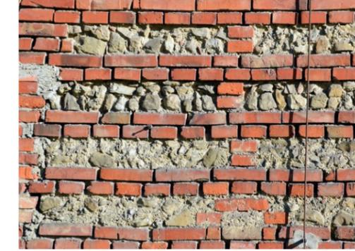
Abb. 18 | Schichtenmauerwerk mit unverputztem Füllmaterial
