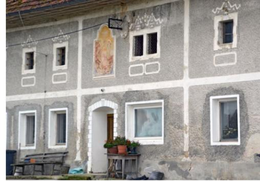
Abb. 50 | Hier wird der Kontrast zwischen den historischen Fenstern im OG und den umgebauten Fenstern im EG deutlich spürbar.
