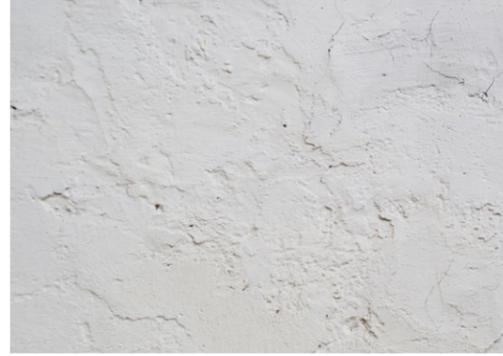
Abb. 16 | Vollflächig verputztes Feldstein-Mauerwerk
