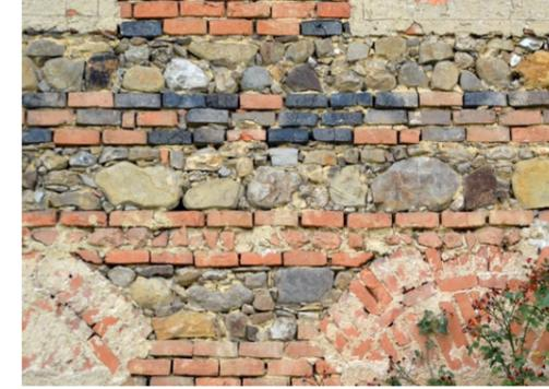
Abb. 17 | Farbenfrohes Schichtenmauerwerk mit unverputztem
