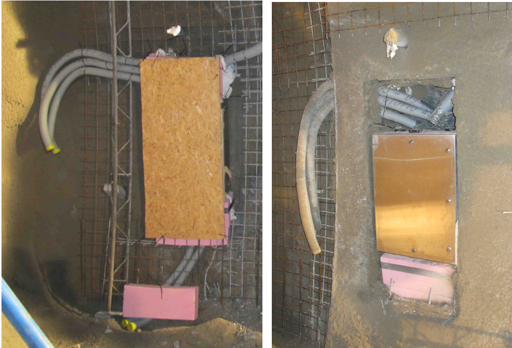
(a) Kabelanschlussbox vor dem Einspritzvorgang mit Holzplatte abgedeckt. (b) Freigelegte Kabelanschlussbox nach dem Einspritzvorgang.
