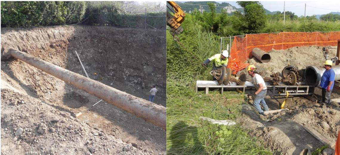
Abbildung 36: Öl-Pipeline (links: freigelegte Pipeline, rechts: Pipeline-Sanierung)<sup>143</sup>
