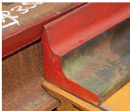
Abbildung 7 Profilanpassung der Zungenschiene [5]
