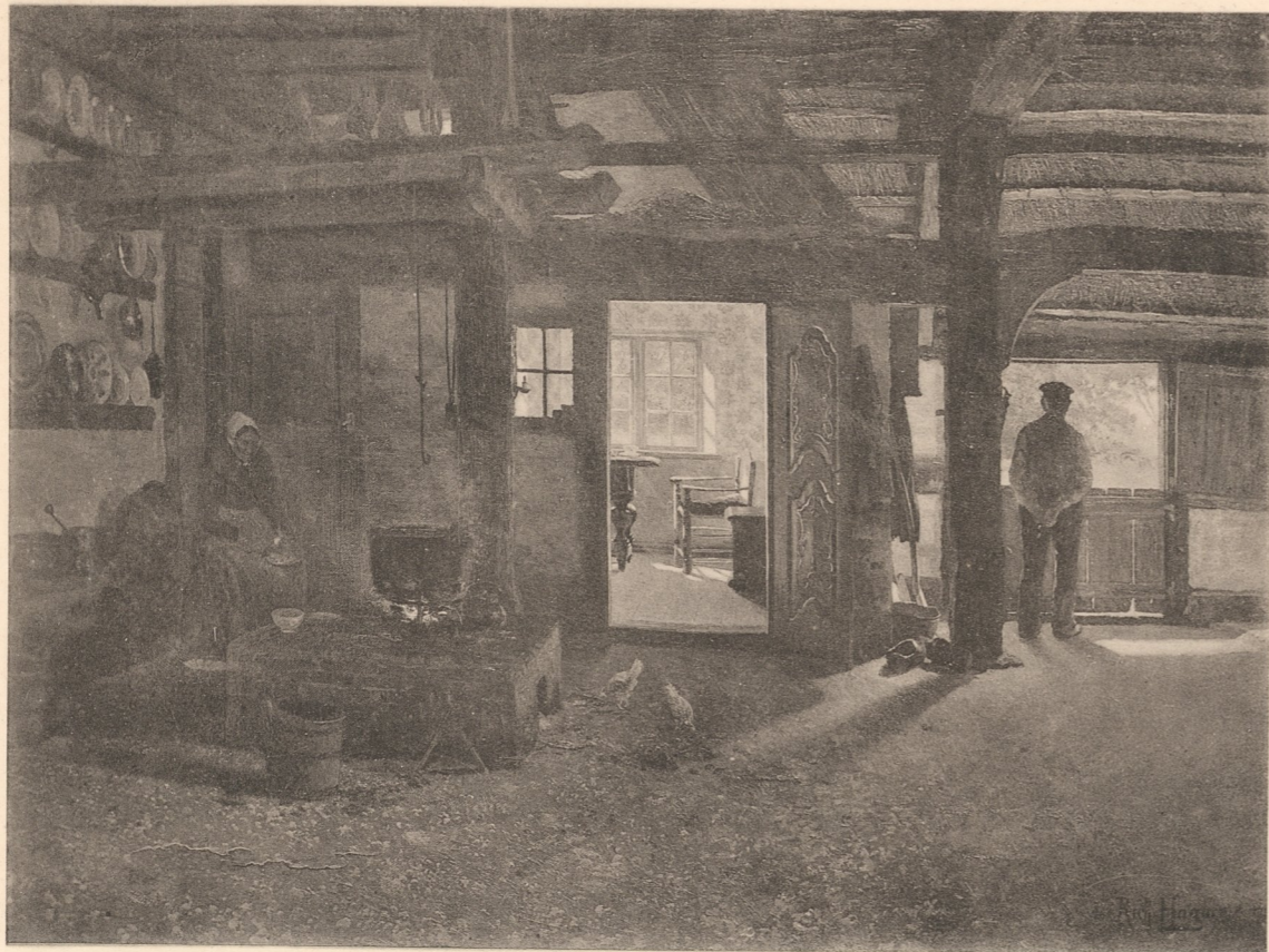
Abb. 1. Diele aus dem Heldt'schen Hause, früher in Ostenfeld, jetzt überführt nach Husum; erb. 1673. (Nach einem Bilde von R. Hagn.)
