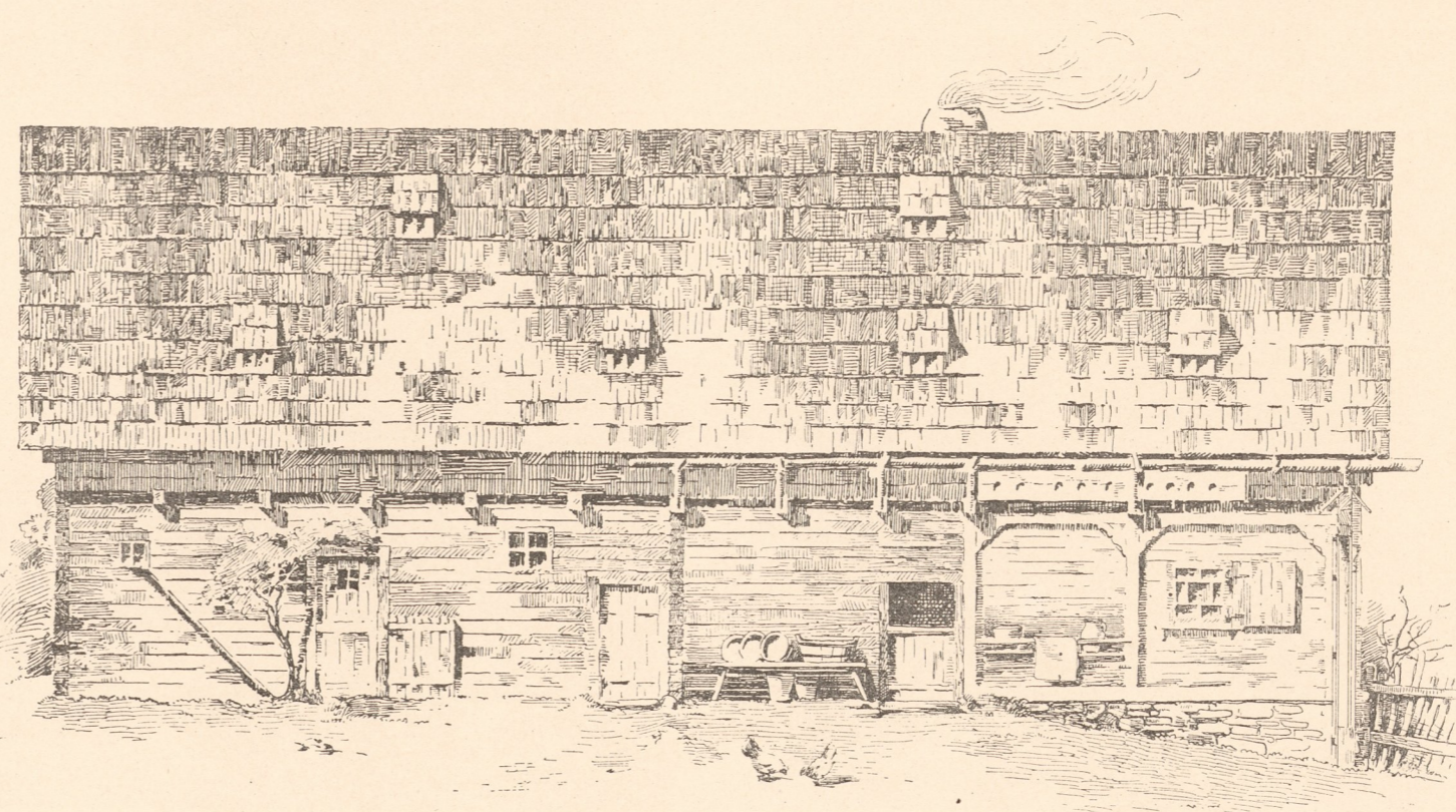
Abb. 2. Hofansicht des Wohngebäudes.
