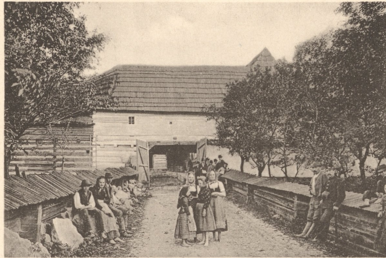
Fig. 1. Ansicht von der Südseite.
