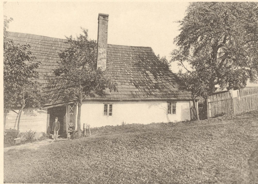
Fig. 8. Aeussere Ansicht von der Westseite.
