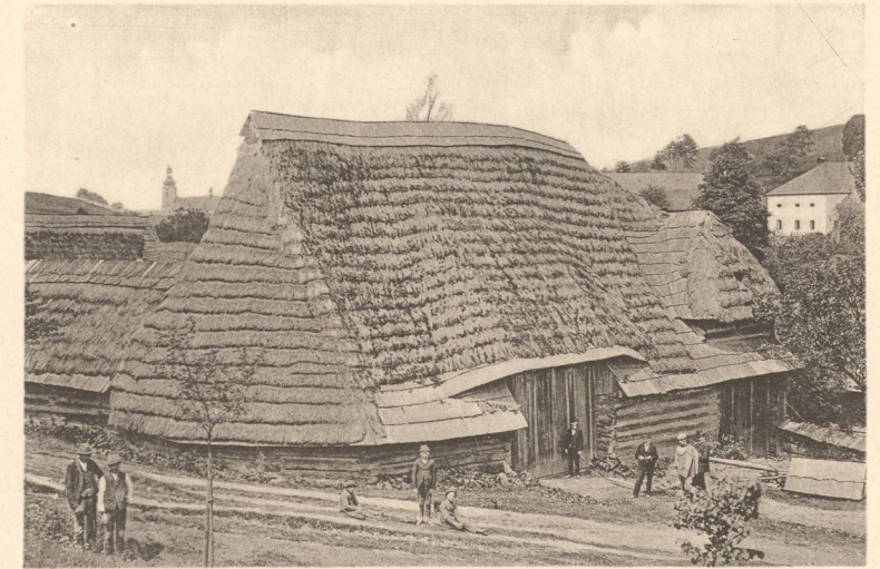
Fig. 2. Blick auf die Scheuer und Scheune.
