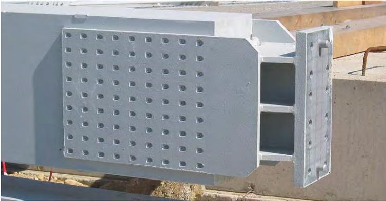
**Abb. 1.1:** Laschen und Kopfplatte für die Verbindung im Stoß des Fachwerk-Untergurtes der Überdachung des VIP-Hangars am Flughafen Wien (Foto: G. Meinhardt)
