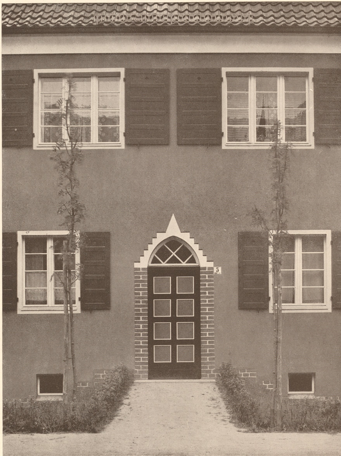
Reihenhäuser an der Camphausenstraße. Teilansicht.
