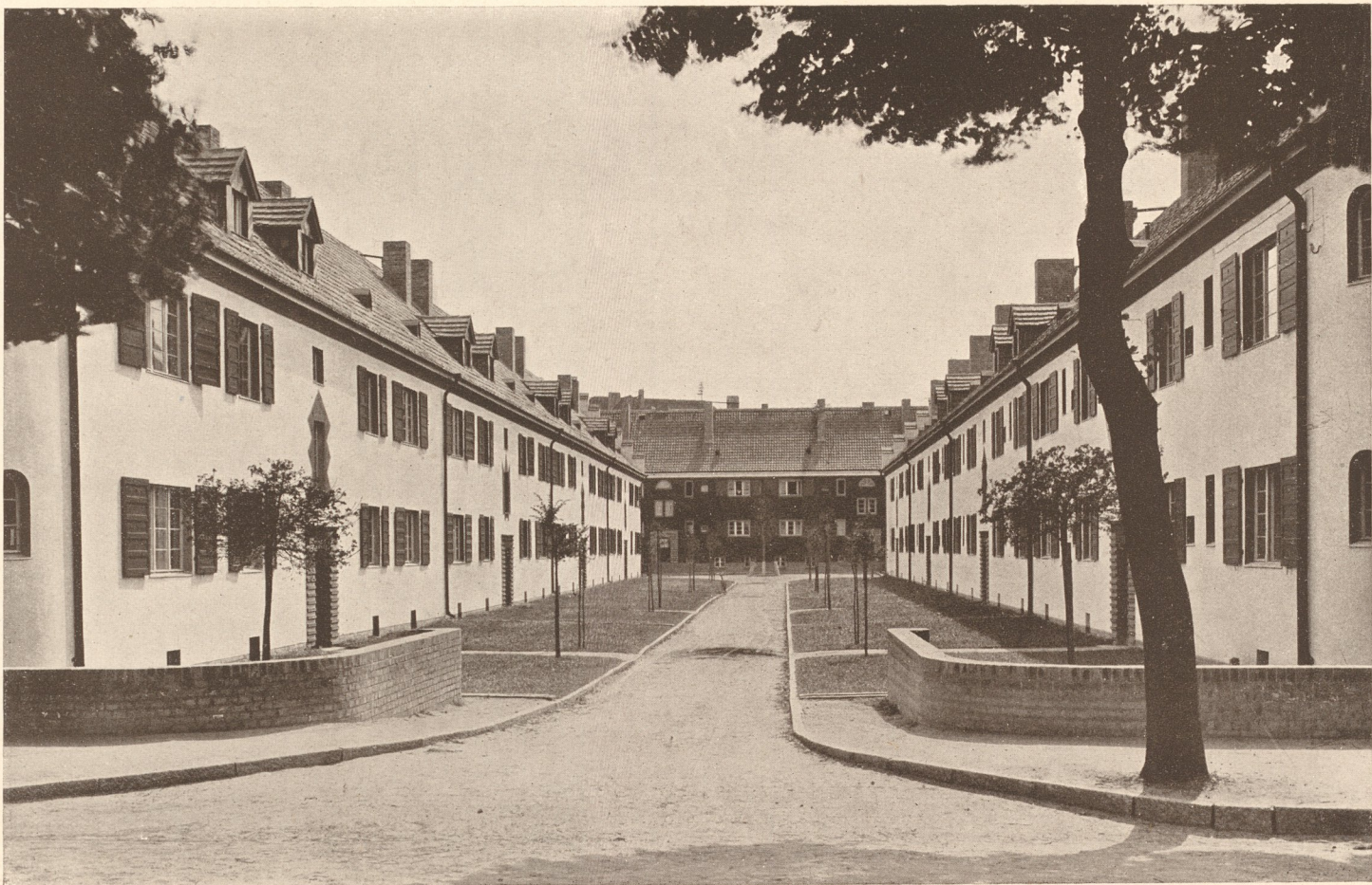
Am weißen Steg. Blickrichtung nach Südosten.
