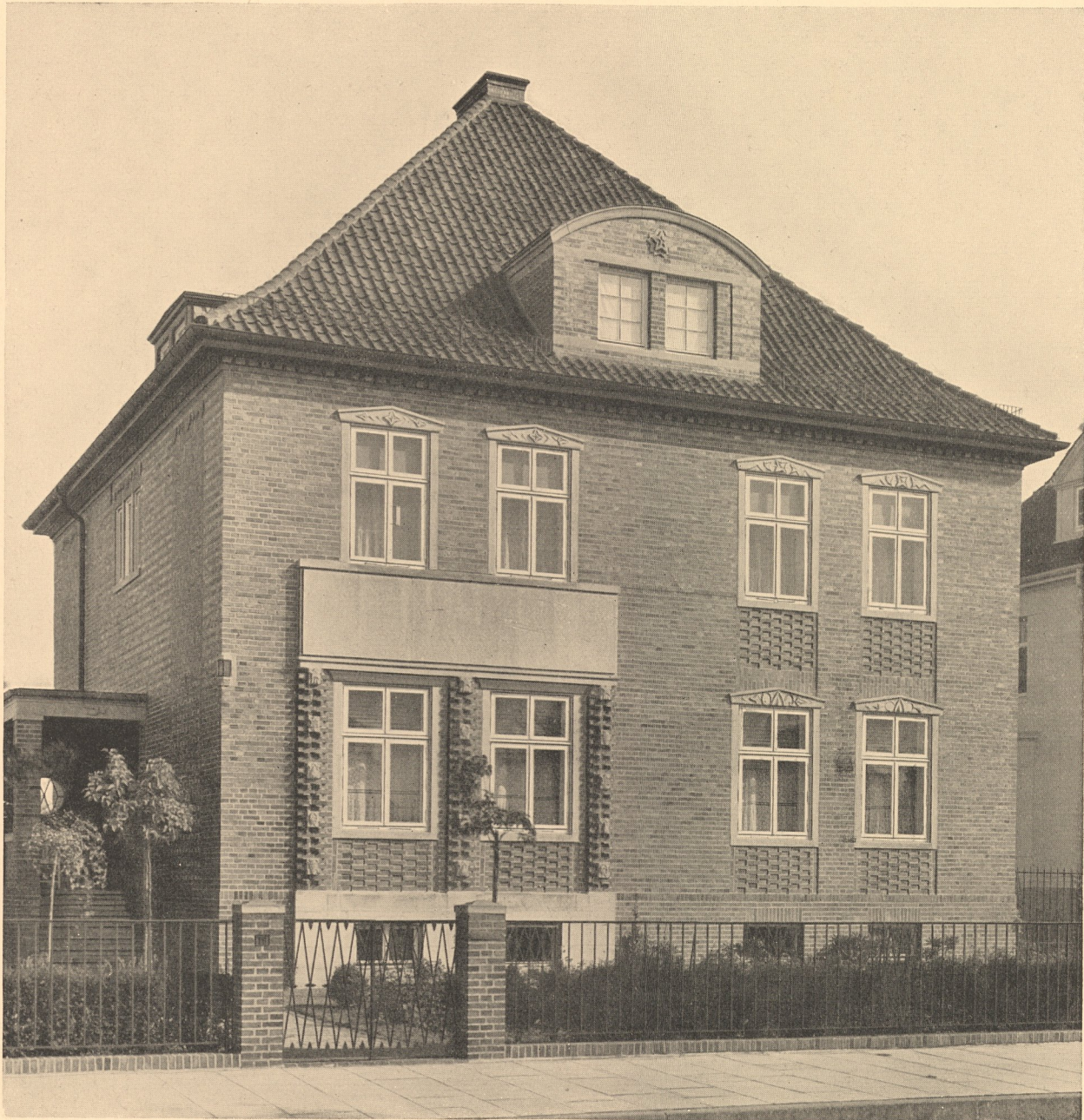
Einfamilienhaus Kurfürstenallee 16, Bremen.
