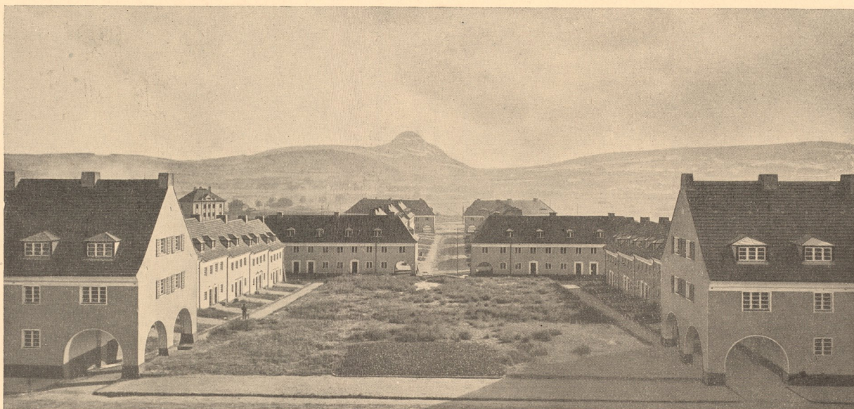
Blick in die Hauptstraße abwärts.
