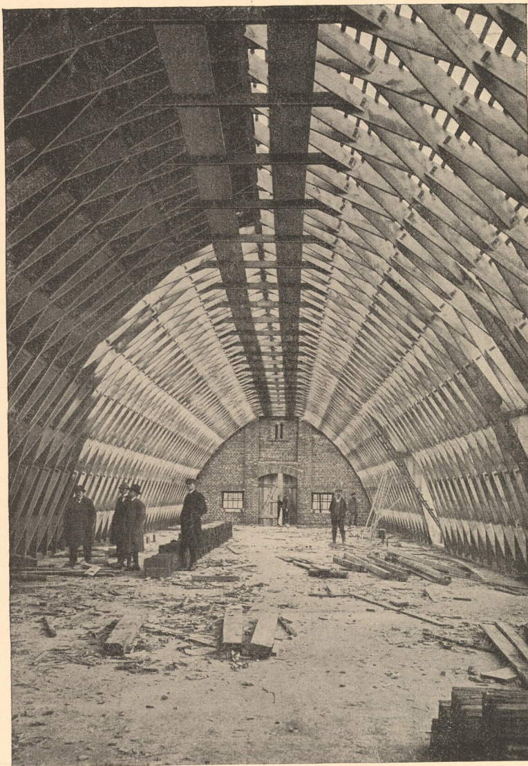
Zollbau-Lamellendach eines Stalles.
