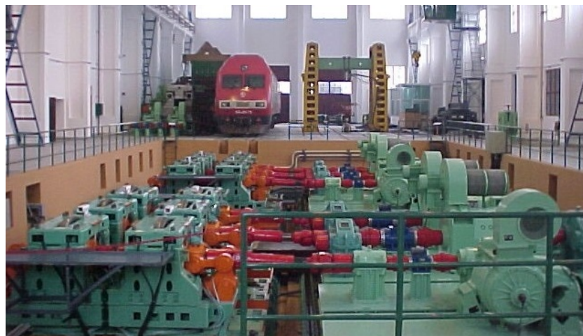
Abbildung 3.12: Rollenanlage in Chengdu [1]
