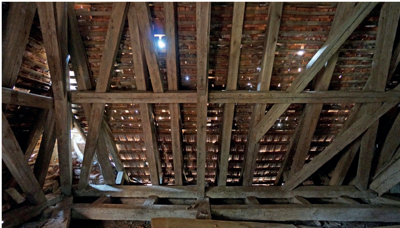
Dachstuhlkonstruktion im Ostrakt
