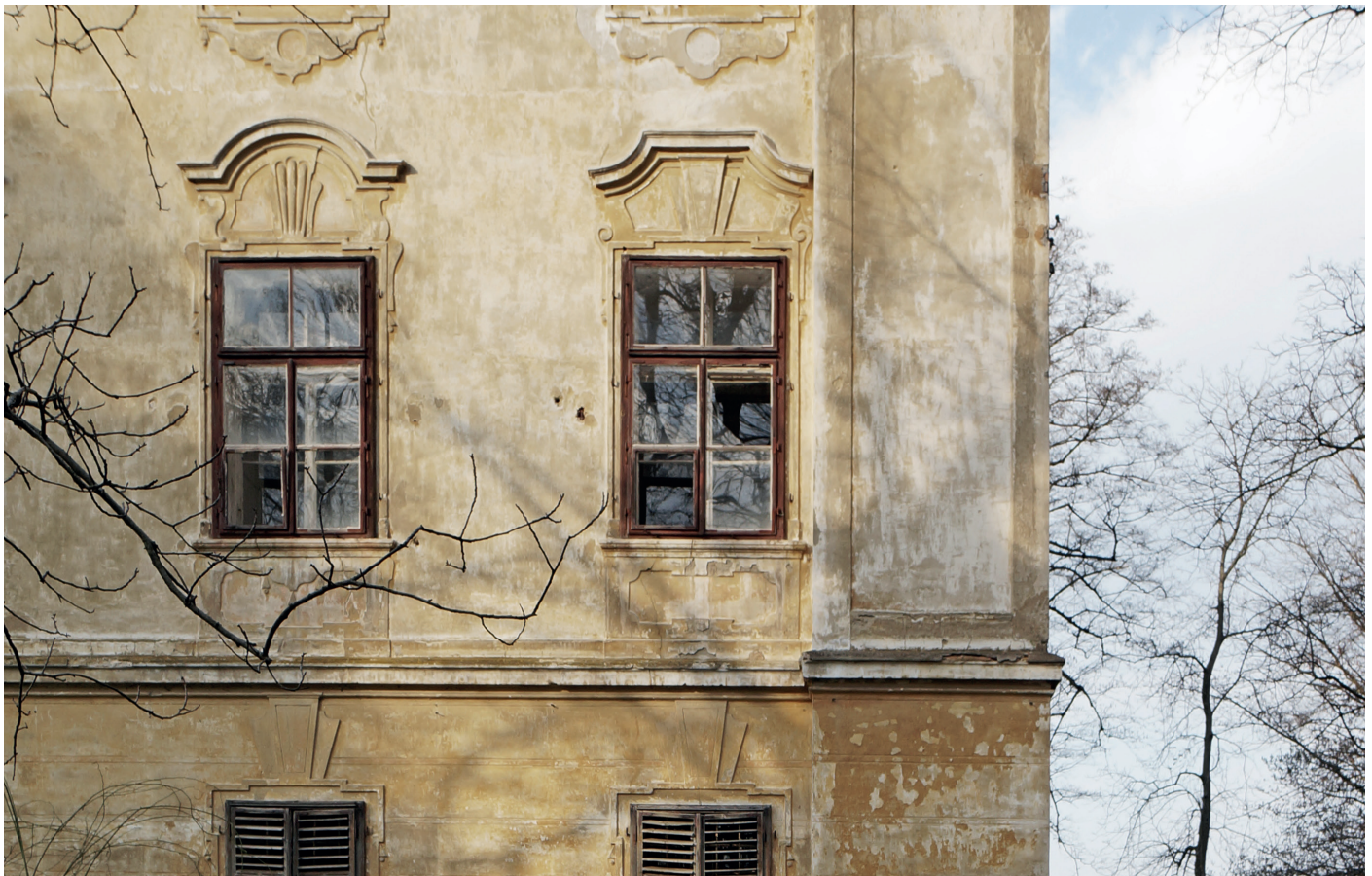
Fassadenausschnitt der Südfassade | Das Nobelgeschoss im ersten Obergeschoss ist durch verschieden geformte Fensterverdachungen betont.
