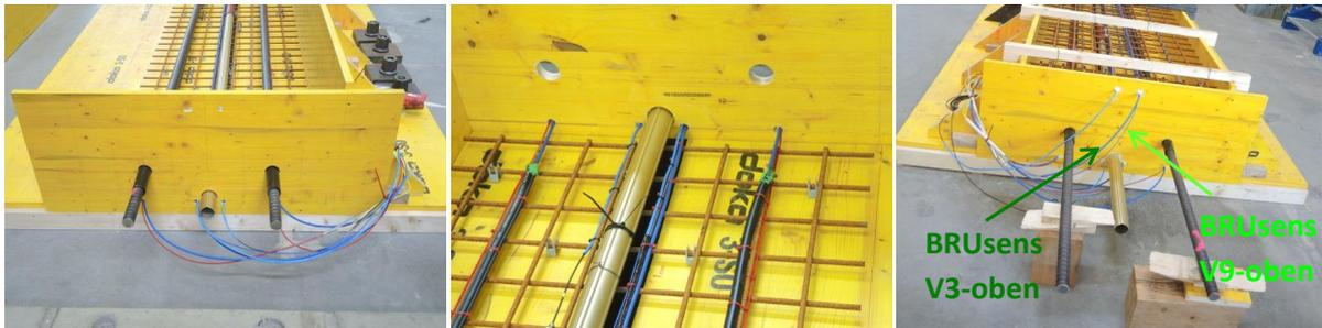
Abbildung 6.2: Stirnseitige Schalung mit durchgezogenen Sensorkabeln (links und Mitte) und Installation der Dehnungssensoren BRUsens V9 und BRUsens V3 an den obere Bewehrungsseisen (rechts)
