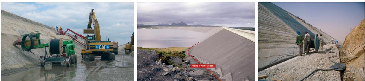
Abbildung 3.11: Einbau der faseroptischen Sensoren bei der Sanierung des Mittleren Isarkanals 1996 (links) und des Midlands Damms auf Mauritius (rechts) sowie der Verlauf des faseroptischen Sensorkabel entlang des Merowe Damms am Nil (Mitte) (nach Aufleger et al. [2007])
