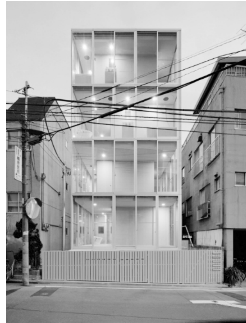
Abb 57:: Ansicht des Gebäudes
