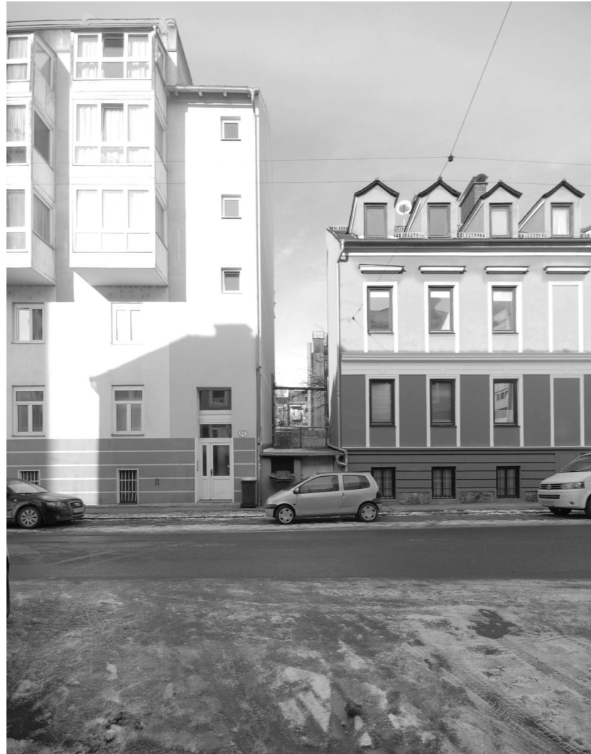
Abb 76:: Frontansicht des Bauplatzes
