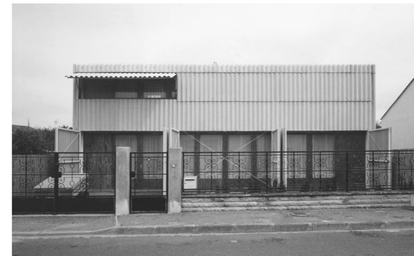
Abb 03:: straßenseitiger Blick auf das Konzepthaus von Lacaton-Vassal
