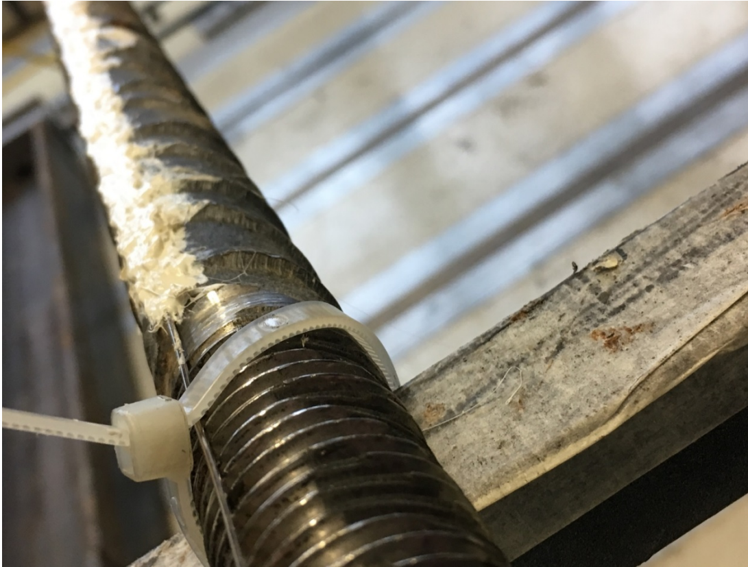
Abbildung 26: SN-Anker - Installation des Messkabels
