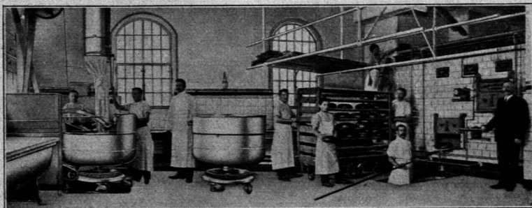
Backofen in einer Backtube mit Teigknetmaschine (Mehl von oben zulaufend) und Einschießbackofen (Fußgrube vor dem Ofen).
