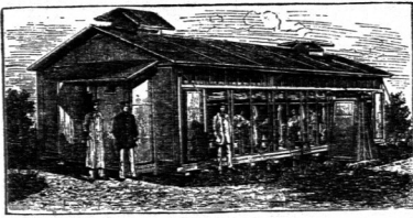
Krankenhaus mit geöffneten Wänden 1893 ).
