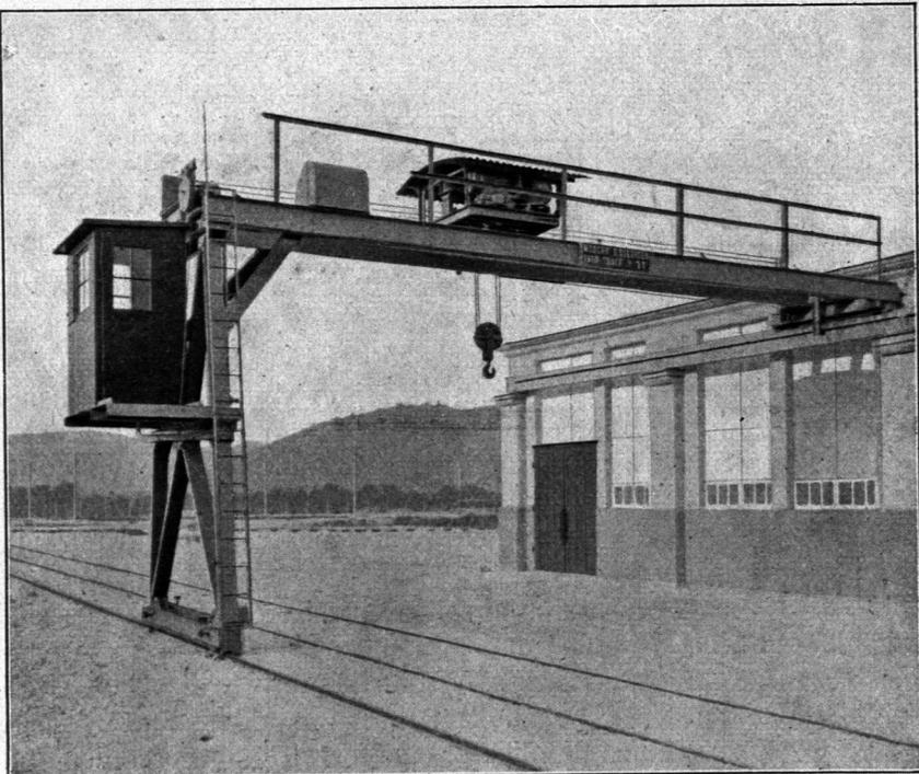
Halbportal-(Winkelportal)-Kran; Tragfähigkeit 3 t. Spannweite 11 m. Nach Ausf. der Maschinenfabrik Esslingen.
