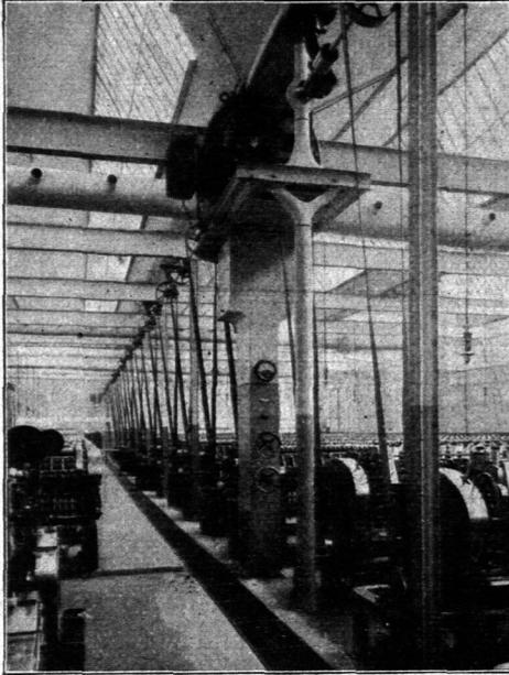
Ein auf einer Stützenkonstruktion aufgebauter Elektromotor zum Antrieb einer Transmiffion: die nach zwei Seiten verlaufenden Wellen sind unmittelbar und starr mit dem Motor gekuppelt. Stromleitungen und kleine Schaltapparate (mit der Dachstütze zusammen) sind eingehäuft.
