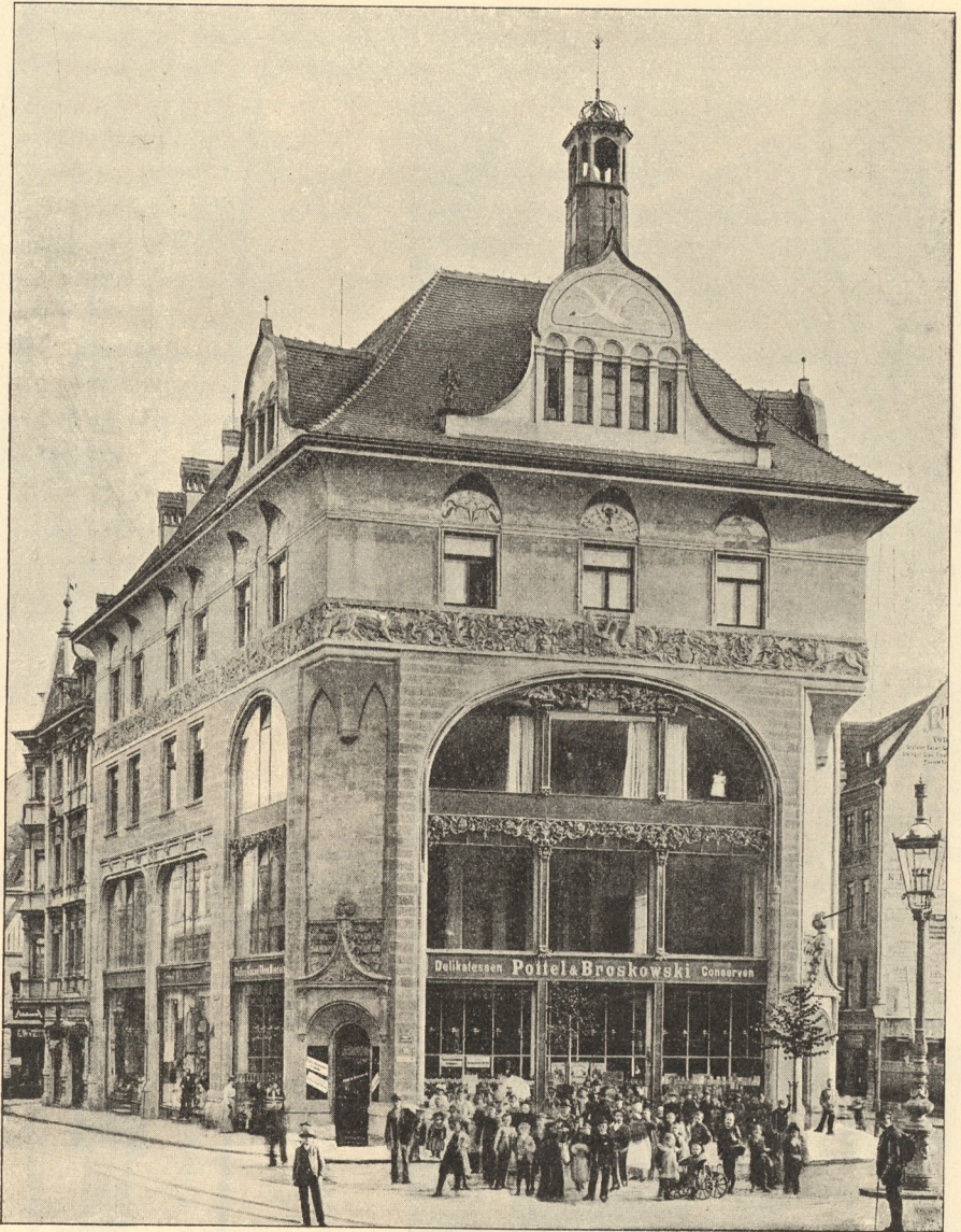
Wohn- und Geschäftshaus zu Halle a. S., Grofse und Kleine Ulrichstraße.
