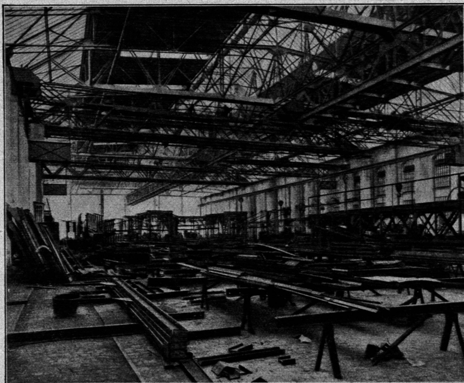
Einschiffige Eisenbauwerkstätte der Maschinenbauanstalt Humboldt in Köln-Kalk.
