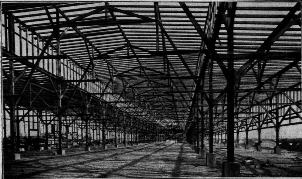
Dreifchiffiger Hallenbau in Holzkonstruktion. Mittelschiff 20<sup>m</sup> breit, Seitenschiff 15<sup>m</sup>, Binderentfernung 9<sup>m</sup>; Lagerhalle im Hamburger Hafen. Erbaut von der Hafenbauverwaltung.
