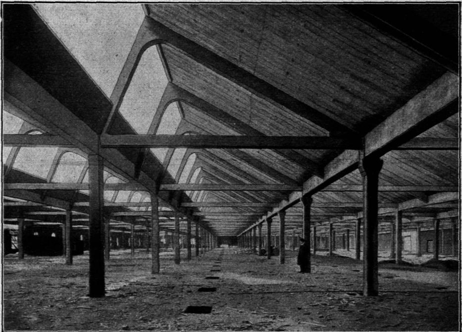
Sägeshed in Eifenbeton mit Zugbalken.
