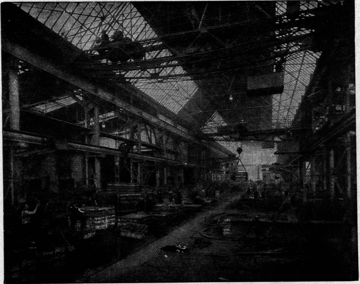
Einblick in die Eifengießerei der Maschinenfabrik R. Wolf -Magdeburg-Salbke; links Kupolofen. Im Vordergrund Gießkafen und Modelle 117) .
