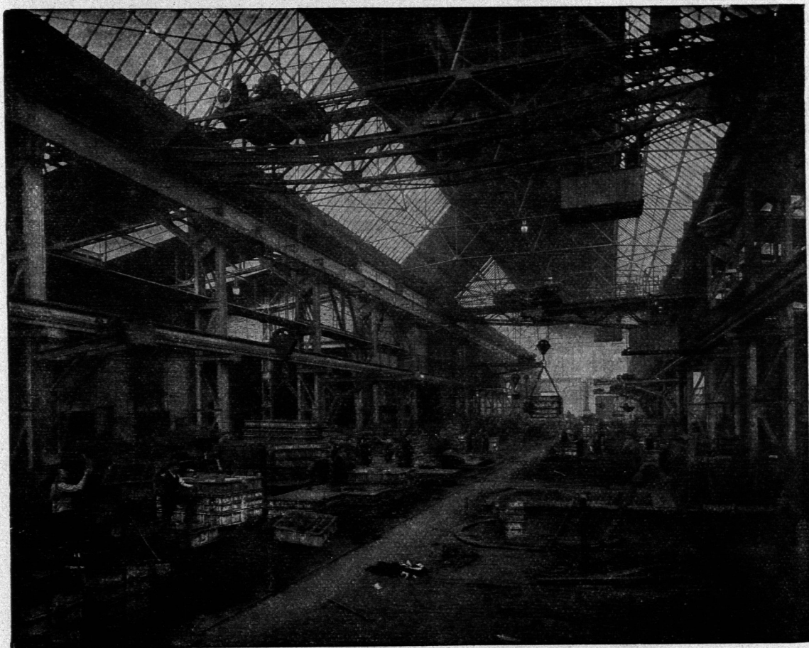
Einblick in die Eifengießerei der Maschinenfabrik R. Wolf -Magdeburg-Salbke; links Kupolofen. Im Vordergrund Gießkanten und Modelle 117) .
