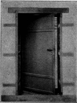
Einfl. eiserne Tür mit befäumtem Eisenblech in eiserner Zarge.
