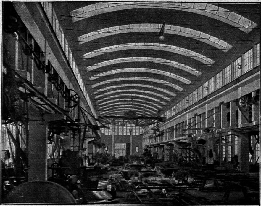
Dreifchiffiger Hallenbau in Eisenbeton. Werkstätte der Intern. Baumaschinenfabrik in Neufstadt a. H. 32)
