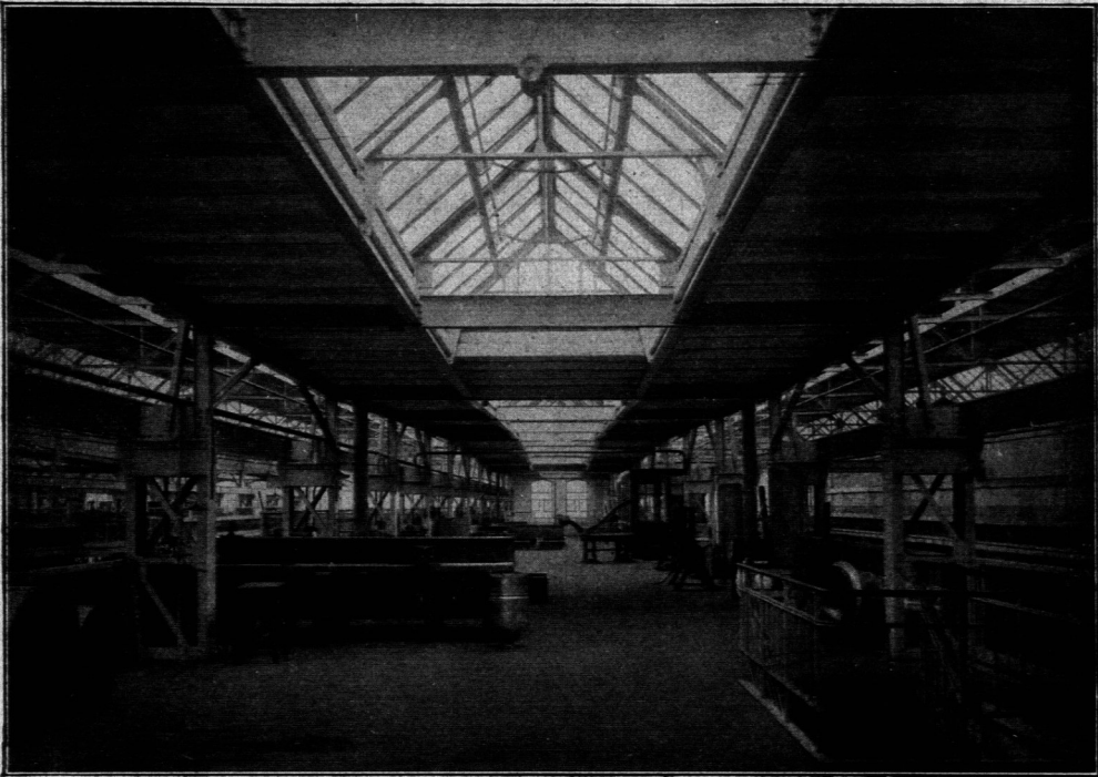
Blick auf die Arbeitsbühne. (Vergl. Fig. 103.)
