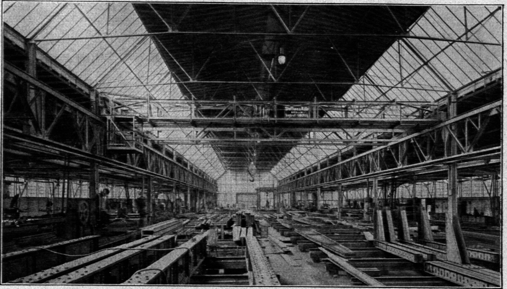
Dreifchiffiger Hallenbau. Mittelschiff 20 m breit. Ausf. der Steffens & Noelle-A.-G. in Berlin-Tempelhof.
