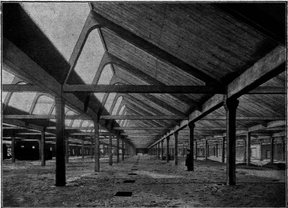
Sägeshed in Eifenbeton mit Zugbalken.
