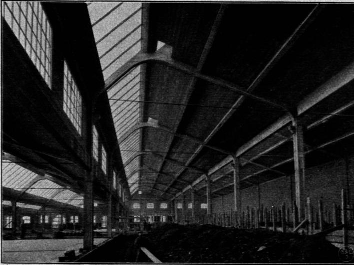
Sägeheddach in Eisenbeton mit Zugband<sup>20)</sup>.
