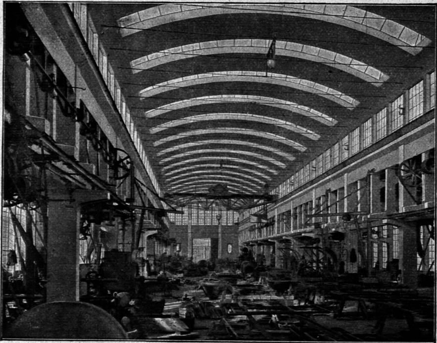
Dreifchiffiger Hallenbau in Eisenbeton. Werkstätte der Intern. Baumaschinenfabrik in Neufstadt a. H.<sup>32)</sup>
