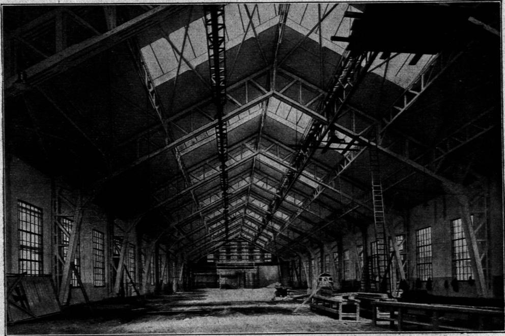
Werkstätte der *Siemens-Schuckert-Werke* Nürnberg; ausgeführt von der Firma Holzbau System *Meltzer* in Darmstadt. Spannweite 26 m.
