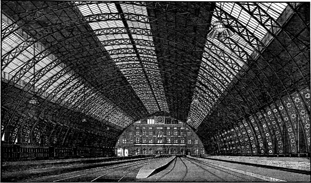
Inneres der Bahnsteighalle auf dem Zentralbahnhof zu New York 300 ).
