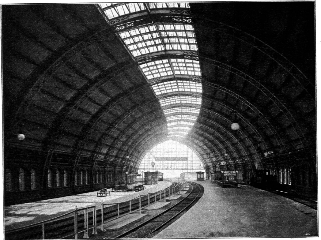
Bahnsteighalle auf dem Bahnhof Friedrichstraße der Berliner Stadt-Eisenbahn.
