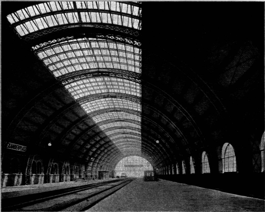
Bahnsteighalle auf dem Bahnhof Alexanderplatz der Berliner Stadt-Eisenbahn.
