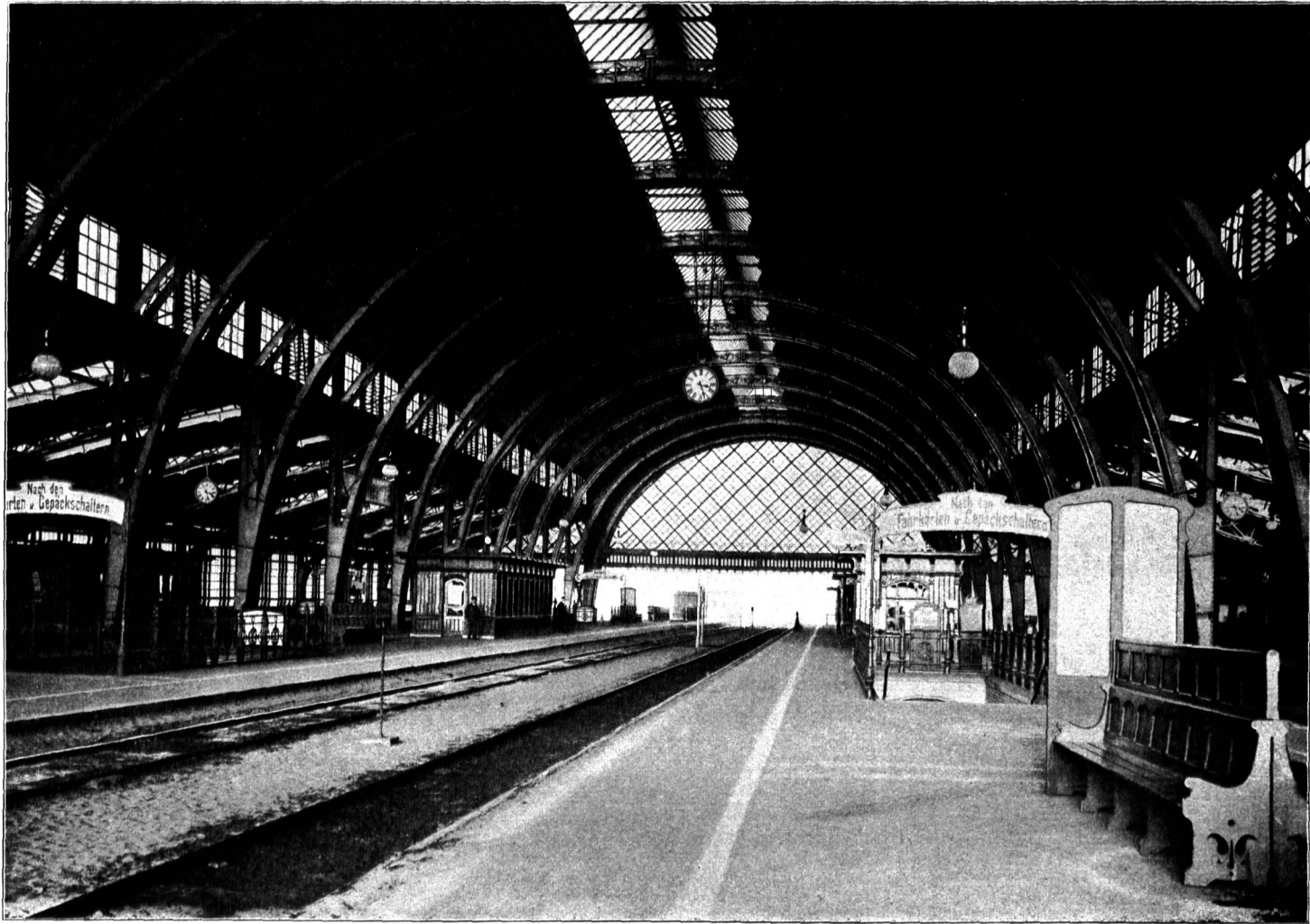
Neue Bahnsteighallen des Bahnhofes zu Dresden-Neustadt.
