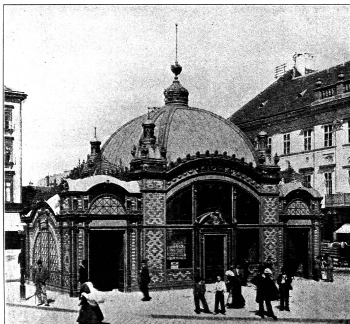
Schutzhäuschen am Deákplatz 215) .
