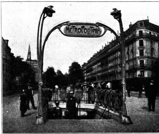
Zugang zur Haltestelle Rue de Rome 204 .
